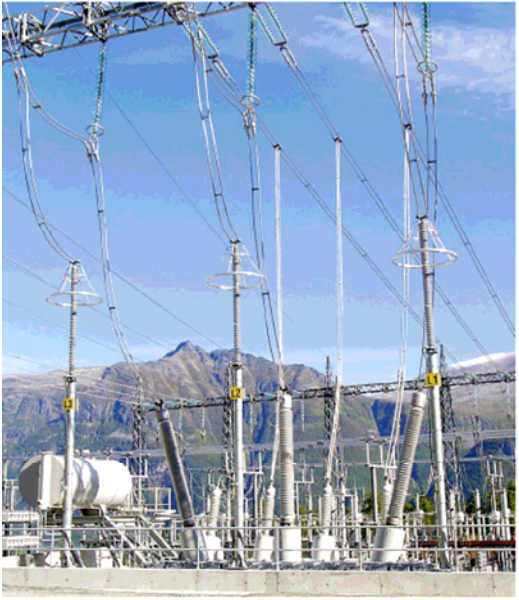
Σχήμα.6: Αλεξικέραυνα 400kV και 150kV με τοροειδή [7]
