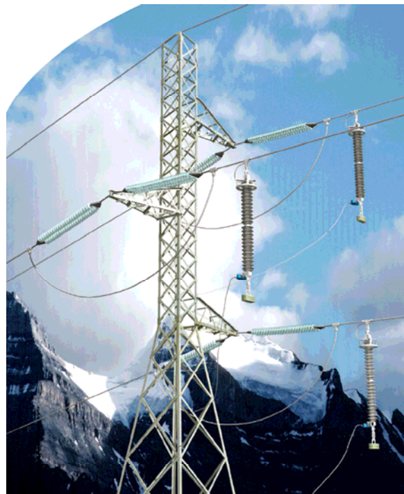
Σχήμα7: Αλεξικέραυνα σε γραμμή μεταφοράς [7]
