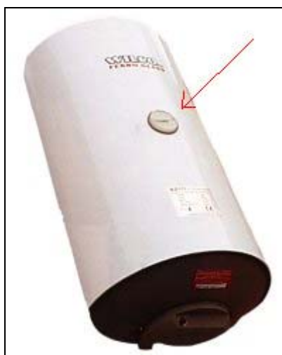
Εικόνα 9. Θέση εισαγωγής του αισθητήρα μας για τη λήψη μετρήσεων θερμοκρασίας
