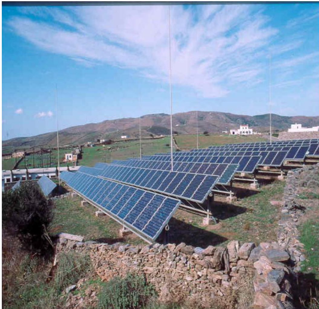
Σχήμα 10: Φ/Β σύστημα 100kWp στην Κύθνο (1983).
