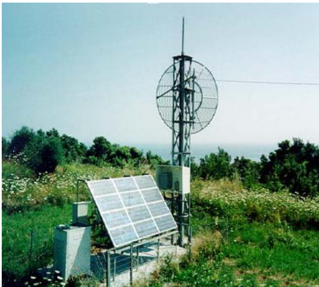
Σχήμα 12: 100 kWp εγκατεστημένα Φ/Β σε αυτόνομα τηλεπικοινωνιακά συστήματα
