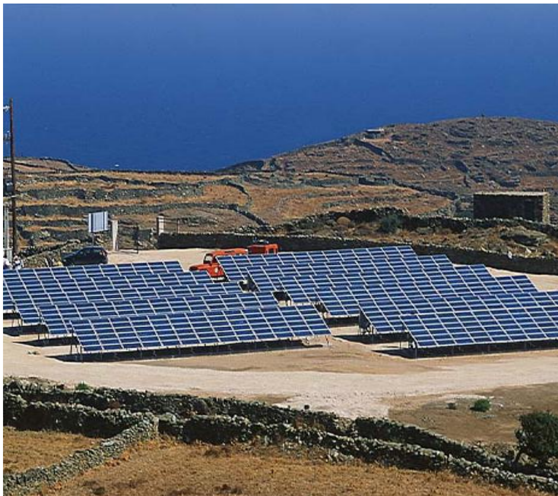
Σχήμα 11: Φ/Β σύστημα 60 kWp στη Σίφνο (1999).
