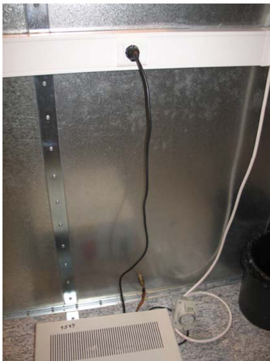
Φωτογραφία 5: Σύνδεση δικτύματος τεχνητού ηλεκτρικού δικτύου με μονοφασική παροχή.
