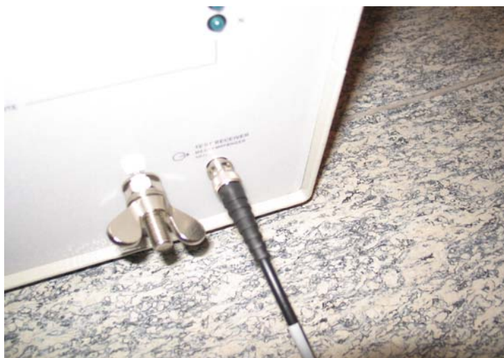
Φωτογραφία 5: Σύνδεση ομοαξονικού καλωδίου με το δίκτυωμα τεχνητού ηλεκτρικού δικτύου.
