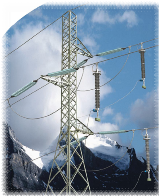
Σχήμα 2.8: Αλεξικέραυνα σε γραμμή μεταφοράς [7]
