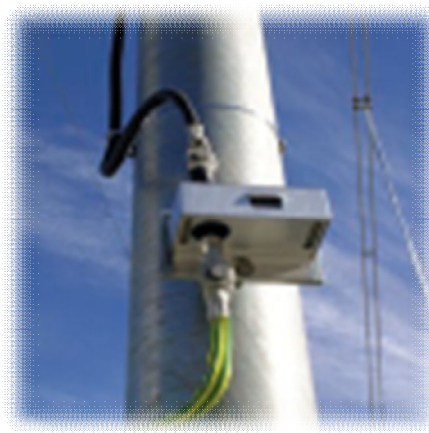
Σχήμα 2.10: Μετρητής Υπερτάσεων [7]
