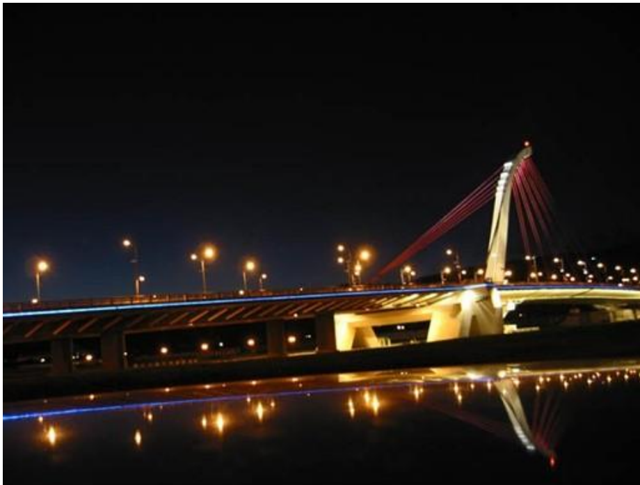
Εικόνα 4-3: Φωτισμός γέφυρας με φωτιστικά Led
