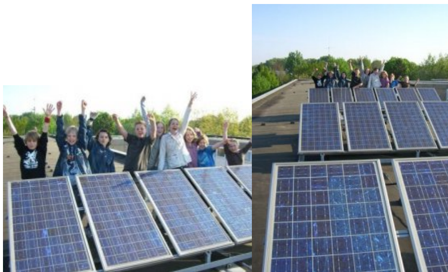
Σχήμα 3.3: Φωτοβολταϊκή εγκατάσταση 1,8KW στο Γυμνάσιο Hummelsbüttel.
