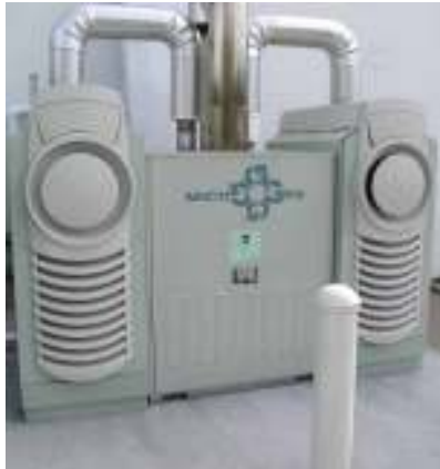
Εικόνα 3.2: Μικροστρόβιλος Capstone με προσαρτημένη μονάδα CHP
