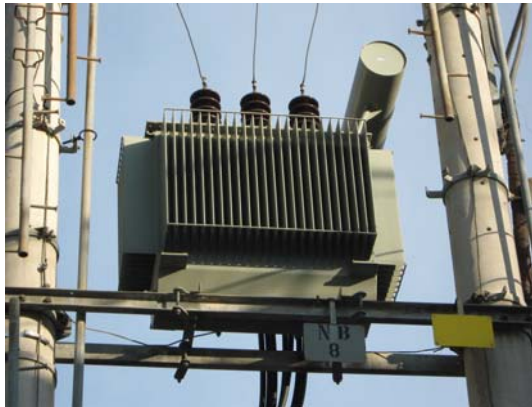
Εικόνα 4.1.10α : Μετασχηματιστής του 10 ου υποσταθμού : Ισχύς - 400 KVA, Θερμοκρασία περιβάλλοντος – 18,3 °C, Σχετική υγρασία – 26,5 %
