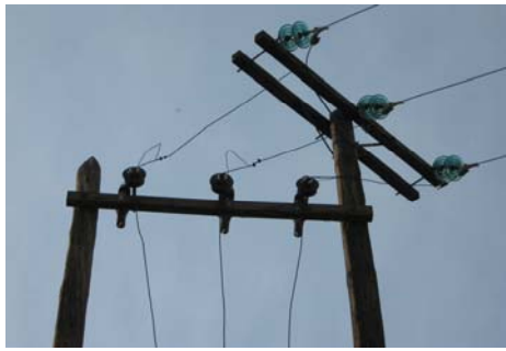
Εικόνα 4.1.9β : Διάταξη ασφαλειών του 9 ου υποσταθμού
