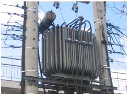
Εικόνα 4.1.8α : Μετασχηματιστής του 8 ου υποσταθμού : Ισχύς - 400 KVA, Θερμοκρασία περιβάλλοντος – 18,1 °C, Σχετική υγρασία – 29,5 %
