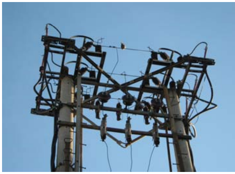
Εικόνα 4.1.7β : Διάταξη ασφαλειών του 7 ου υποσταθμού
