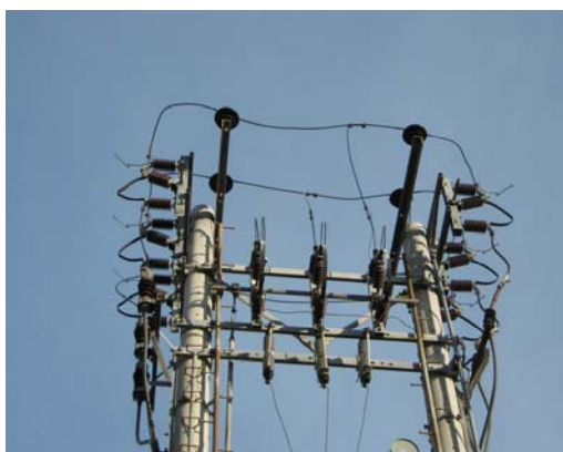
Εικόνα 4.1.10β : Διάταξη ασφαλειών του 10 ου υποσταθμού
