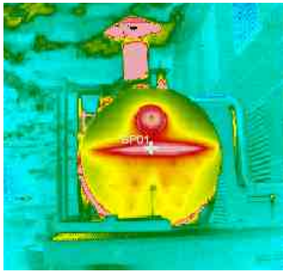
Εικόνα 3.4.4: Θερμογραφήματα λέβητα και σωληνώσεων
