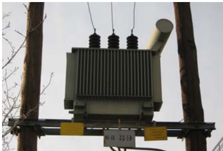
Εικόνα 4.1.9α : Μετασχηματιστής του 9 ου υποσταθμού : Ισχύς - 400 KVA, Θερμοκρασία περιβάλλοντος – 19 °C, Σχετική υγρασία – 27,5 %
