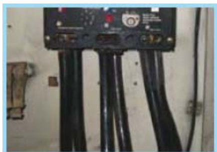
Εικόνα 3.7.1 : Τριφασική διάταξη – παρατηρείται αυξημένη θερμοκρασία στην μια από τις τρεις φάσεις
