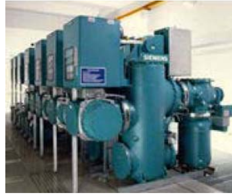
Σχήμα 1.2.2-2 : Διακόπτης ισχύος 550 kV [18].
