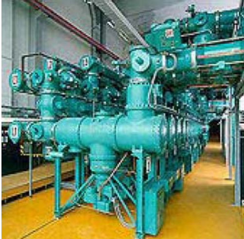
Σχήμα 1.2.2-2 : Διακόπτης ισχύος 550 kV [18].
