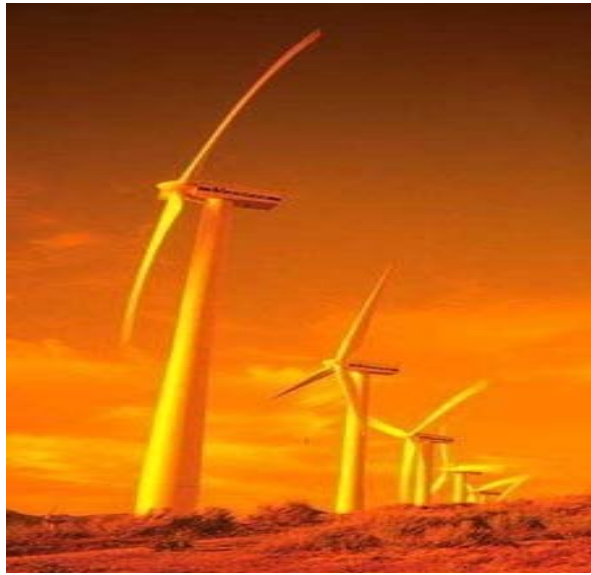
Σχ. 3.17 Onshore αιολικό πάρκο.
