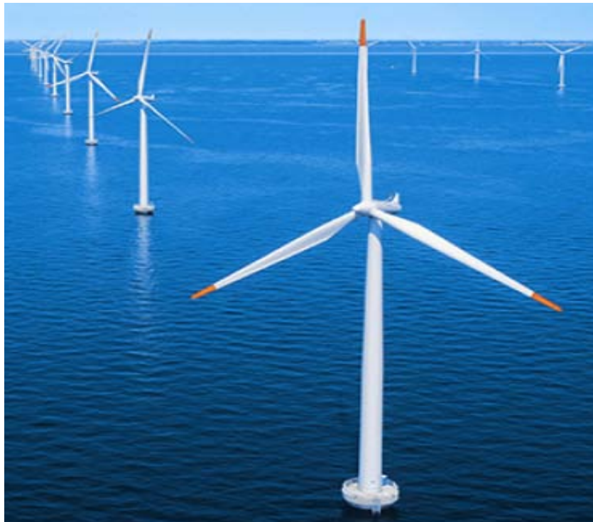
Σχ. 3.19 Offshore αιολικό πάρκο.
