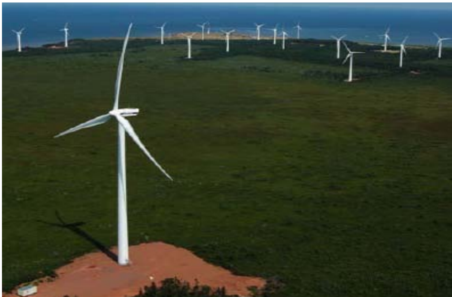
Σχ. 3.18 Nearshore αιολικό πάρκο.
