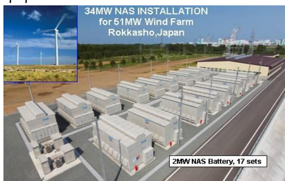
Εικόνα 5.6. Εγκαταστάσεις μπαταριών θειούχου νατρίου
