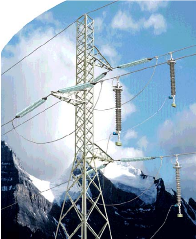
Σχήμα 2.7: Αλεξικέραυνα σε γραμμή μεταφοράς [13]
