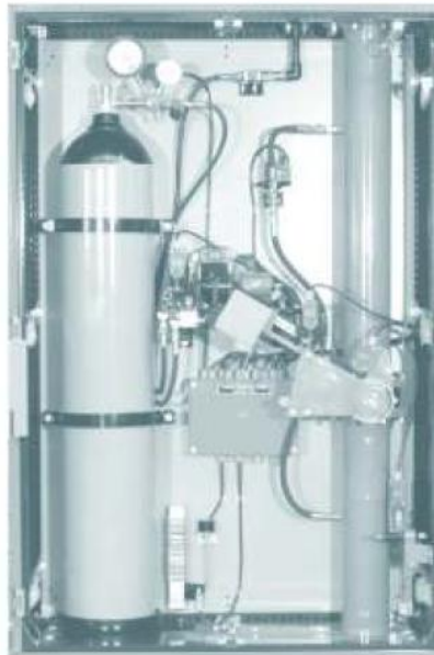
Σχήμα 3.5.9-2: Εσωτερικό του θαλάμου εξάλειψης πυρκαγιάς
