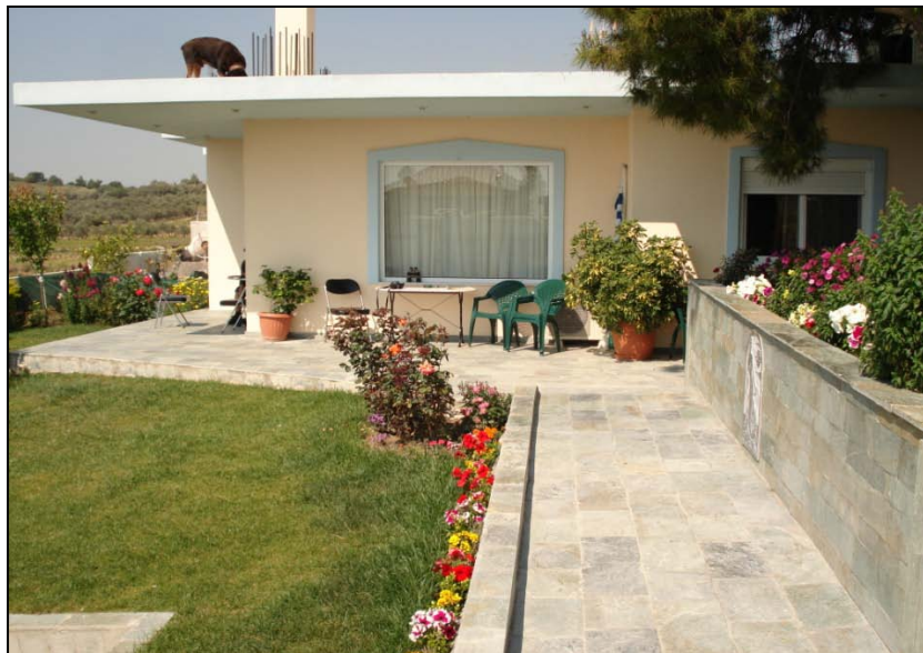
Εικόνα 2.1: Μονοκατοικία στην περιοχή των Σπάτων Αττικής (φαίνεται η ανατολική πλευρά του σπιτιού)
