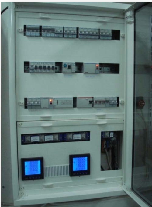
Εικόνα 8.17: Γενικός πίνακας μικροδικτύου
