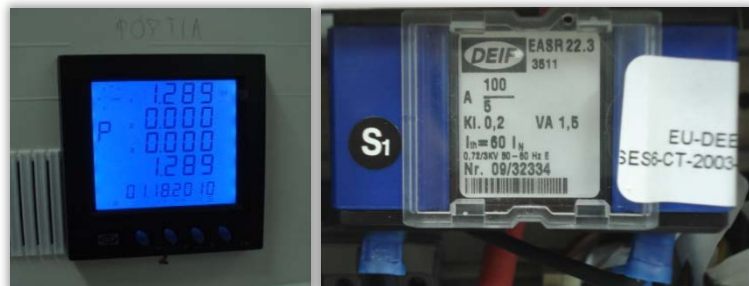
Εικόνα 8.13 : Πολυόργανο φορτίων και μετασχηματιστής έντασης
