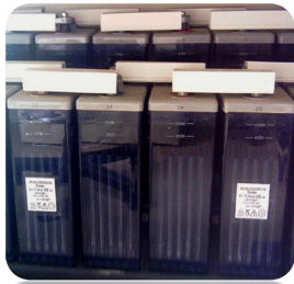
Εικόνα 8.5 : Συσσωρευτές εργαστηριακού μικροδικτύου
