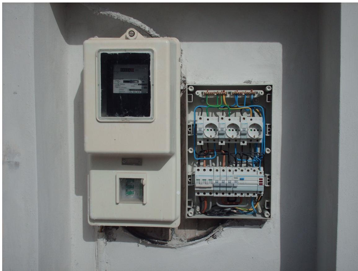
**Εικόνα 2.3-1: Εργοταξιακός πίνακας που τροφοδοτείται από το τριφασικό εργοταξιακό ρεύμα**
