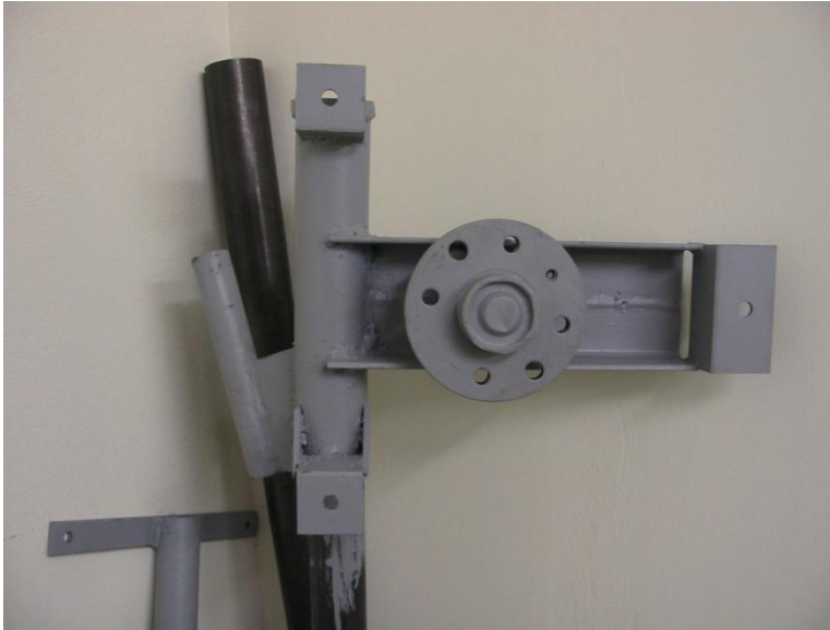
Σχήμα 5.6: Η χαλύβδινη κατασκευή στήριξης.
