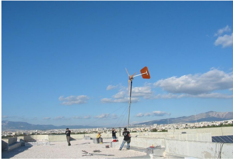
Σχήμα 2.8: Ανύψωση της ανεμογεννήτριας που κατασκευάστηκε στην πολυτεχνειούπολη Ζωγράφου
