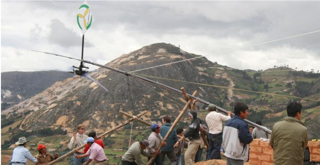
Σχήμα 1.2: Στιγμιότυπο από την εγκατάσταση μικρής ανεμογεννήτριας σε αγροτική κοινότητα στο Περού.
