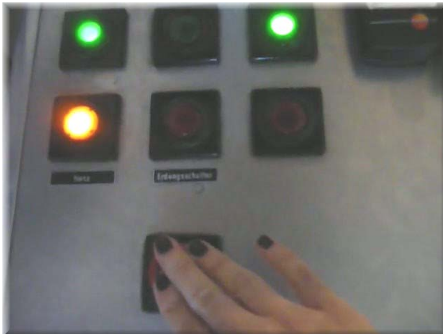
Σχήμα 2.18 Ενεργοποίηση διακόπτη ταχείας θέσεως-αποκοπής τάσης.
