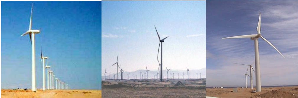
Σχήμα 5.10 Τα στάδια κατασκευής του αιολικού πάρκου στη Zafarana
