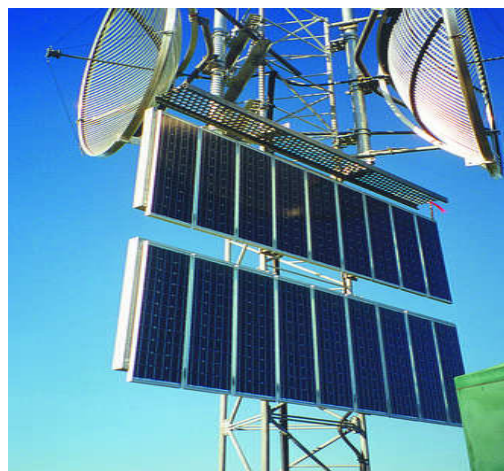
Σχήμα 2.6 Ηλιακό σύστημα τηλεπικοινωνιών
