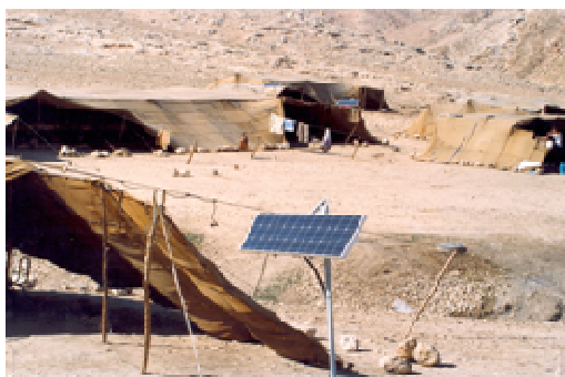
Σχήμα 6.5 Φωτοβολταϊκά συστήματα για την ηλεκτροδότηση οικισμού Βεδουίνων
