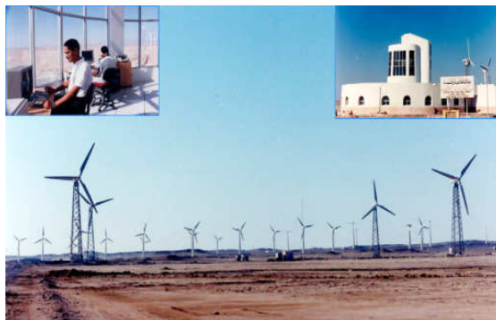
Σχήμα 5.9 Το αιολικό πάρκο στην Hurghada
