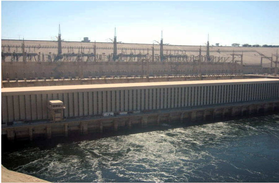
Σχήμα 5.4 Το υδροηλεκτρικό φράγμα του Ασουάν
