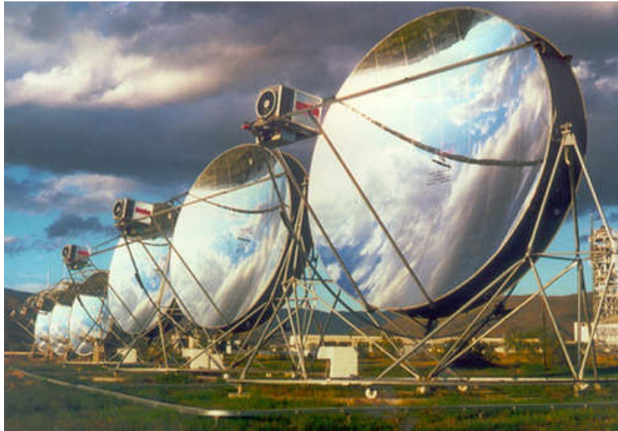
Σχήμα 4.20 Εστιακά κάτοπτρα συγκέντρωσης ηλιακής θερμικής ενέργειας
