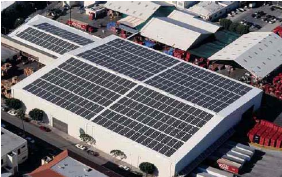
Εικόνα 3.9: Φωτοβολταϊκές διατάξεις ενσωματωμένες σε κτίρια
