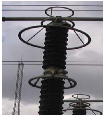
Σχήμα 3.5: Διάταξη καθοδικών αλεξικέρανων με δακτύλιους [2]
