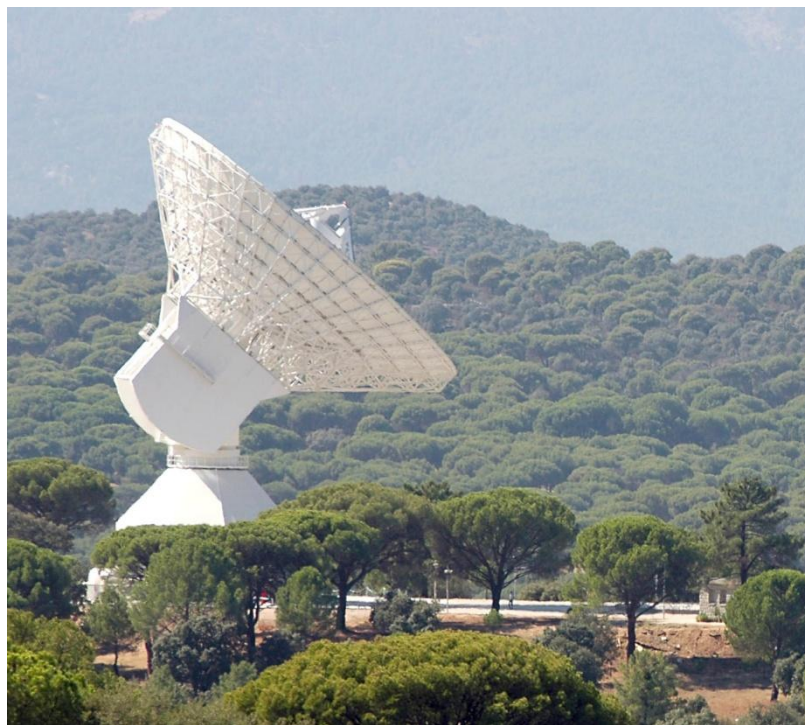
Σχ. 1.6 Παραβολική κεραία 34m στο συγκρότημα βαθέως διαστήματος του οργανισμού ESA (Cebreros, Ισπανία)
