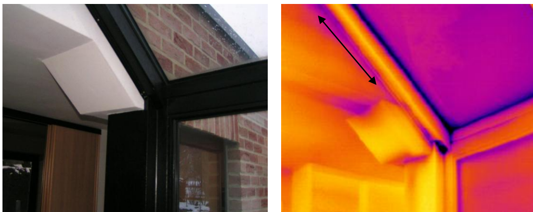
Εικόνα 2.1: Ένωση τοίχου με αλουμίνιο
