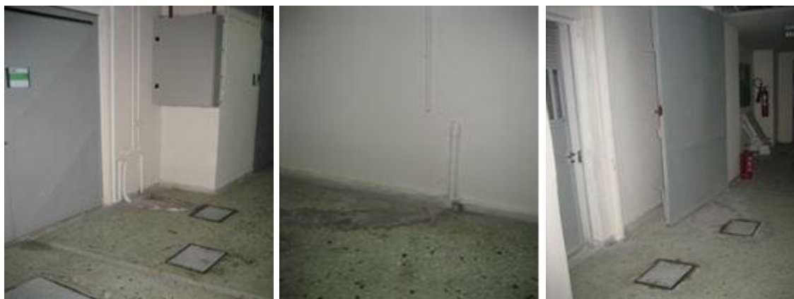
Εικόνα 5.23: Υπόγειο (Χώρος Υ44)
