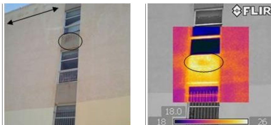
Εικόνα 5.11: Διαφορετικό Υλικό Κατασκευής (Χώρος 001)
