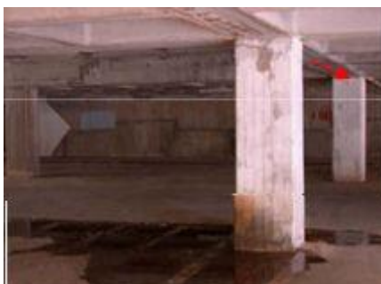
Εικόνα 2.12: Αρμός διαστολής στην οροφή – Πλατεία κέντρου πολυτεχνειούπολης Ζωγράφου
