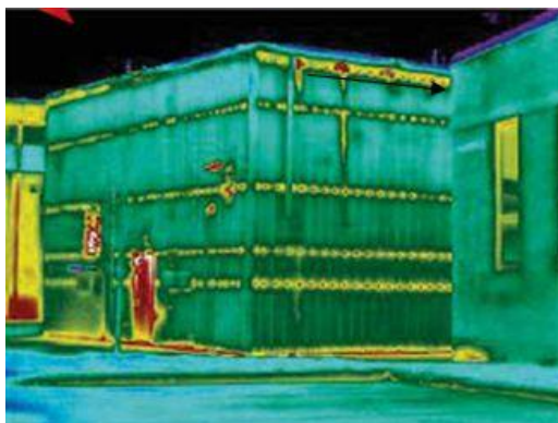
Εικόνα 3.6: Συνδεσμολογία μεταλλικών πάνελ
