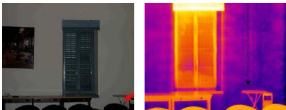
Εικόνα 2.35: Θέση ρευματοδότη – «Φαρμακείο» (ΤΠΠΑ)
