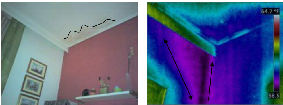
Εικόνα 2.39: Υγρασία και μούχλα
