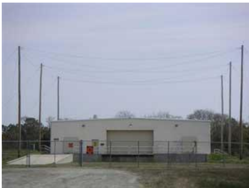
Εικόνα 4.1 Παράδειγμα εγκατάστασης αποθήκευσης πυρομαχικών του αμερικανικού ναυτικού [7]. Σε τέτοιες περιπτώσεις η χρήση απομονωμένου ΣΑΠ είναι προτιμητέα.
