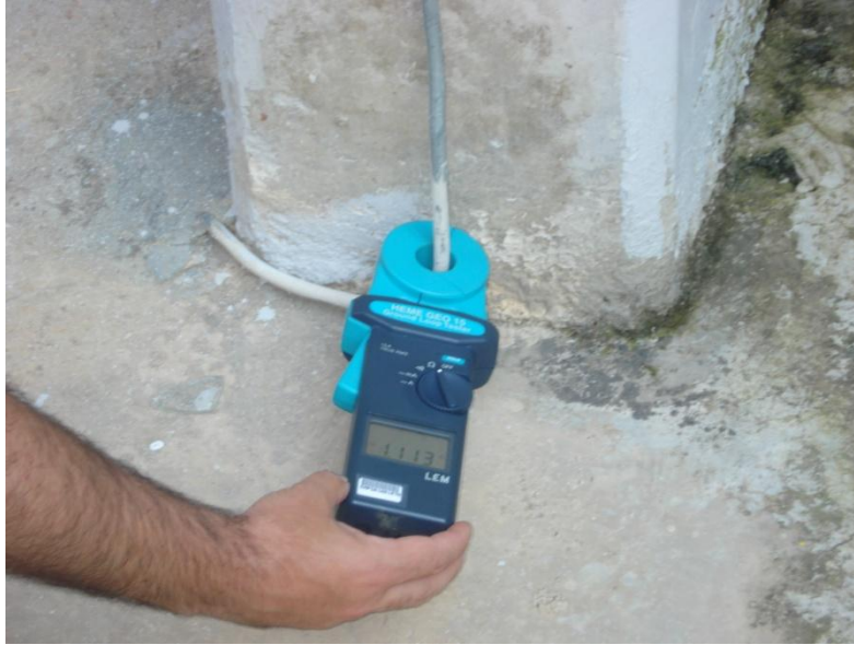
Εικόνα 6.7 Ψηφιακό ωμόμετρο τύπου τσιμπίδας του εργαστηρίου υψηλών τάσεων του ΕΜΠ (Φωτογραφία που λήφθηκε κατά τη διάρκεια μέτρησης αντίστασης γείωσης).
