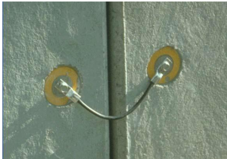
Εικόνα 5.4: Ισοδυναμική διασύνδεση οπλισμού παρακείμενων τμημάτων [18].
