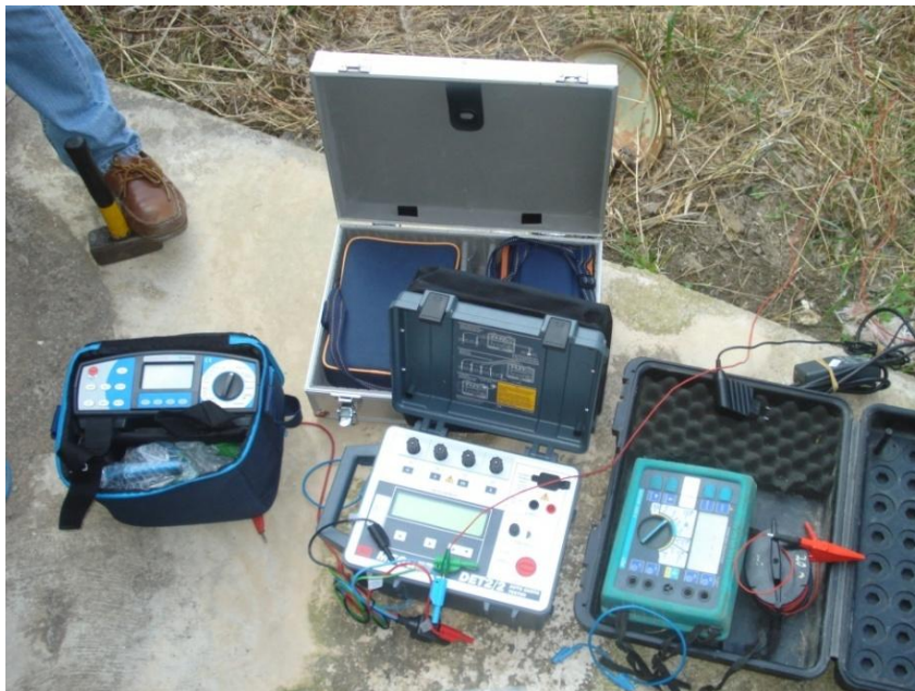
Εικόνα 6.6 Συσκευές μέτρησης της γείωσης του εργαστηρίου υψηλών τάσεων του ΕΜΠ. Απαραίτητη προϋπόθεση για μια σωστή μέτρηση είναι η διακρίβωση του οργάνου από αναγνωρισμένο για τον σκοπό αυτό φορέα (Φωτογραφία που λήφθηκε κατά τη διάρκεια μέτρησης αντίστασης γείωσης)
