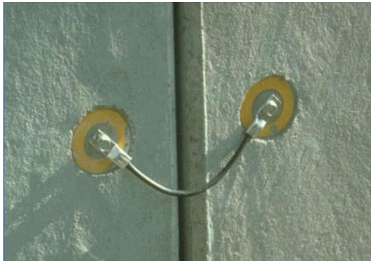
Εικόνα 5.4: Ισοδυναμική διασύνδεση οπλισμού παρακείμενων τμημάτων [18].
