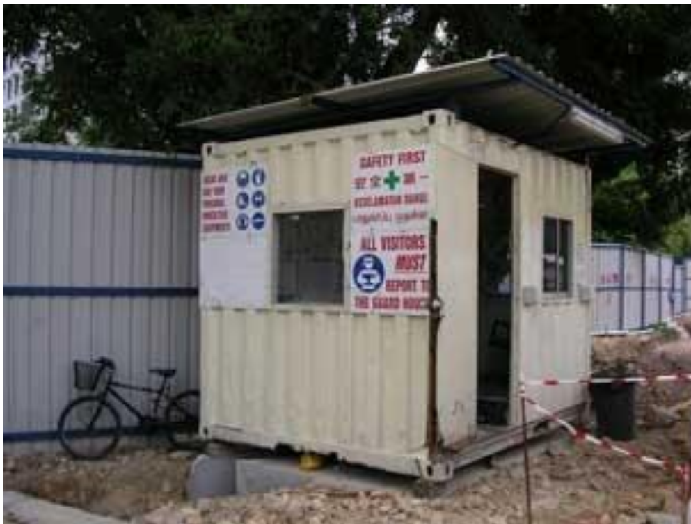
Εικόνα 6.2 Παράδειγμα μεταλλικού καταφυγίου αντικεραυνικής προστασίας (κλωβός Quasi-Faraday) [7].
