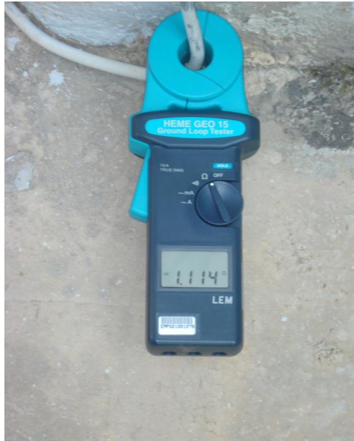
Εικόνα 6.8 Μέτρηση με το ψηφιακό γεισόμετρο τύπου τσιμπίδας σε αγωγό καθόδου που συνδέεται σε θεμελιακή γείωση αν και δείχνει μια μικρή τιμή δεν αποφαίνεται για την τιμή της γείωσης (Φωτογραφία που λήφθηκε κατά τη διάρκεια μέτρησης αντίστασης γείωσης).
