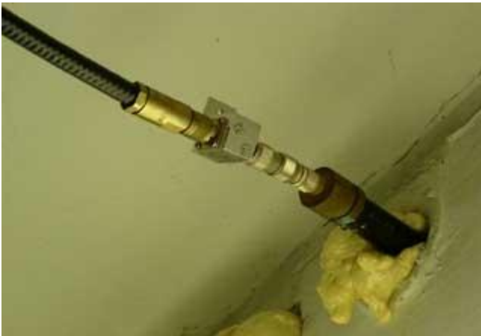
Εικόνα 6.5 Παράδειγμα SPD καλωδίου σήματος το οποίο δεν γειώνεται με αποτέλεσμα να μην παρέχεται προστασία [7].
