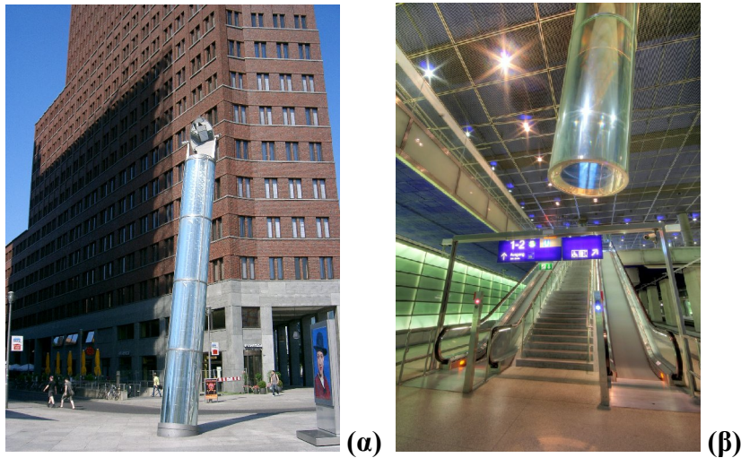
Σχήμα 6.2.14 Φωτοσωλήνας με ηλιοστάτη στην κορυφή (α) για τη συγκέντρωση ηλιακού φωτός και τη διάχυσή του με φωτοσωλήνα (β) στον υποκείμενο σταθμό μετρό της Potsdamer Platz Βερολίνου.
