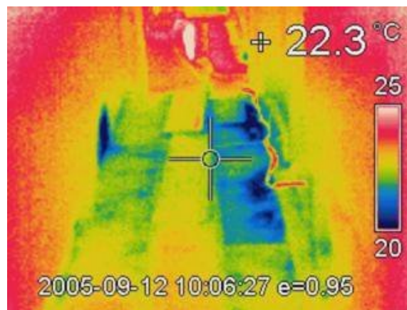
Εικόνα 3.3.4.16 Υποδαπέδιες διαρροές εξαιτίας λανθασμένης εγκατάστασης σωληνώσεων
