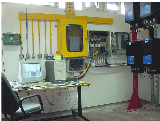
Εικόνα 4.1.5 Αντιστροφείς DC > AC
