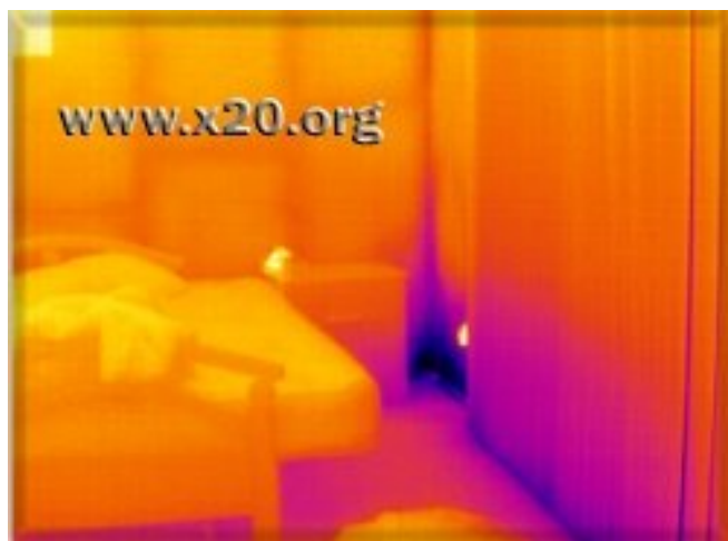
Εικόνα 3.3.6.7 Διείσδυση κρύου αέρα σε κατοικία
