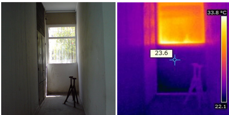
Εικόνα 5.2.7 Γωνία του κτιρίου στο ισόγειο από το πλαϊνό μέρος του κτιρίου
