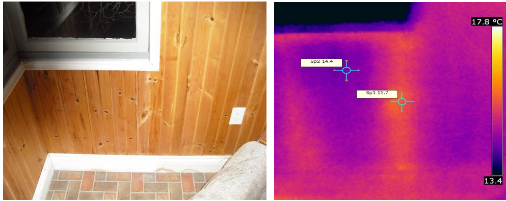
Εικόνα 3.3.5.7 Ζημιά από διείσδυση νερού κάτω από το παράθυρο
