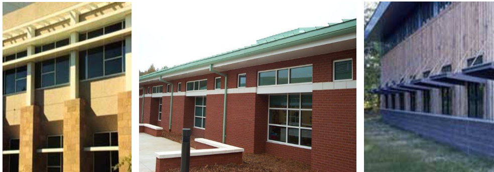
Σχήμα 6.2.9 Εξωτερικά ράφια φωτός (light shelves).
