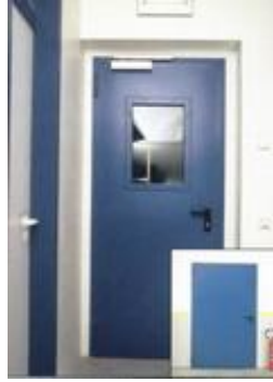
Εικόνα 17: Θύρες πυρασφάλειας
