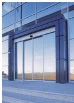
Εικόνα 16: Άποψη εξωτερικής συρόμενης θύρα με ανιχνευτή κίνησης
