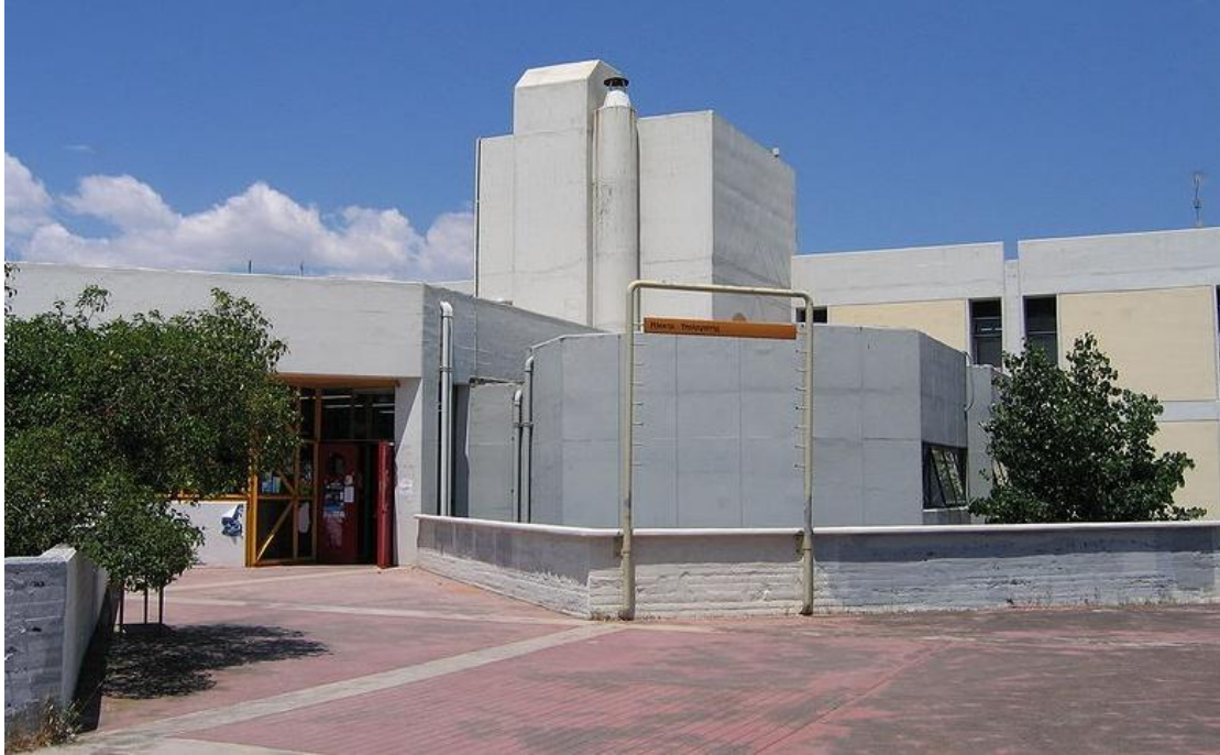
Σχήμα 4.2: Είσοδος πρώτου ορόφου κτιρίου Η/Υ
