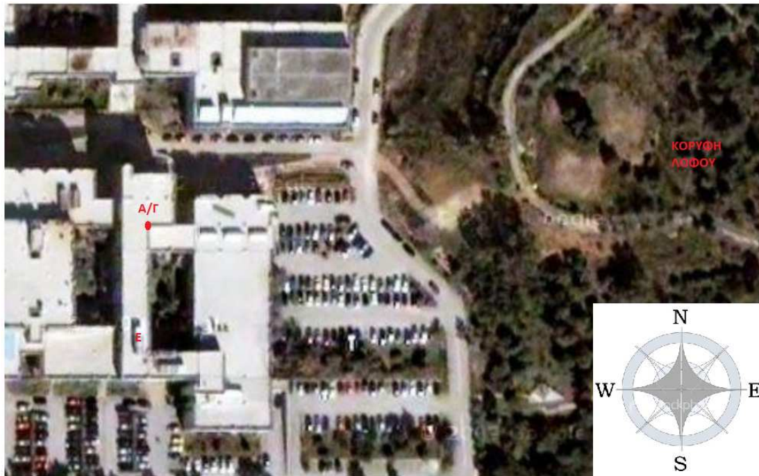
Εικόνα 3.4 : Στην αεροφωτογραφία φαίνονται οι διαστάσεις της οροφής του παλιού κτιρίου της Σχολής ΗΜΜΥ, η θέση της εγκατεστημένης Α/Γ, οι αποστάσεις από τα γειτονικά κτίρια βόρεια και δυτικά και από το λόφο στα ανατολικά. Επίσης φαίνεται η απόσταση από το εμπόδιο Ε που υπάρχει στην οροφή. (Φωτογραφία πριν την εγκατάσταση του μετεωρολογικού ιστού)
