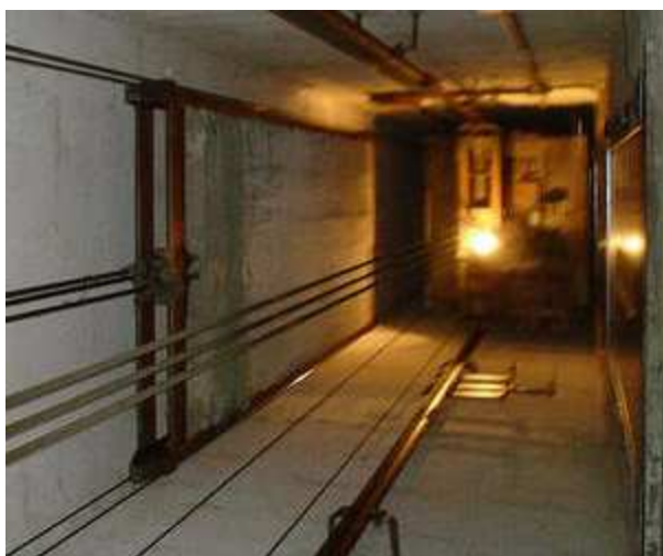
Σχήμα 1.2.2.3-1 : Φρεάτιο ηλεκτροκίνητου ανελκυστήρα έλξεως [3].
