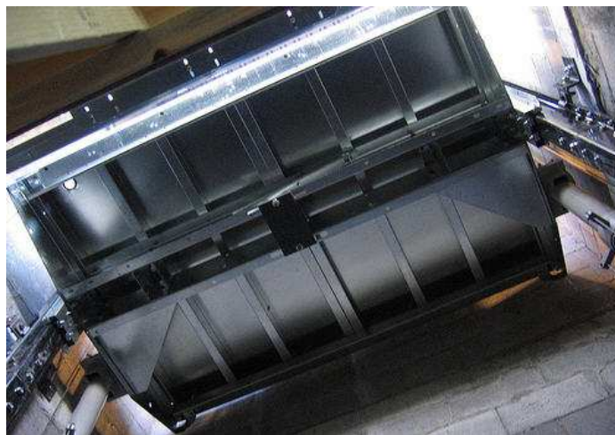
Σχήμα 1.3.3.1.3-1 : Άμεση ανάρτηση υδραυλικού ανελκυστήρα τύπου J3 [3].
