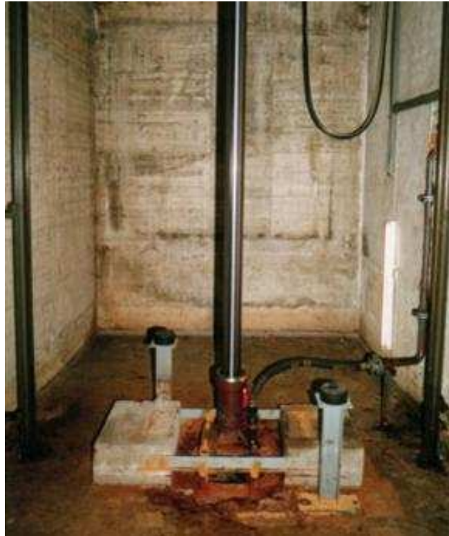
Σχήμα 1.3.3.1.1-1 : Άμεση ανάρτηση υδραυλικού ανελκυστήρα τύπου J1 [3].
