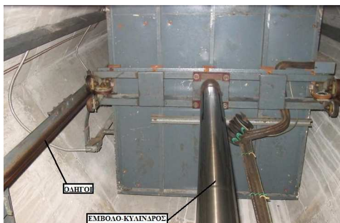
Σχήμα 1.3.2.4-1 : Φρεάτιο υδραυλικού ανελκυστήρα [3].
