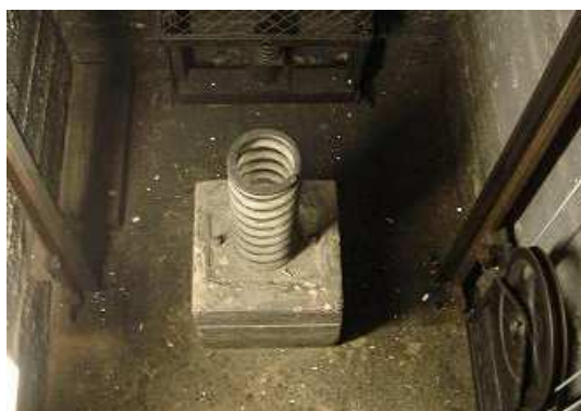
Σχήμα 1.2.2.6.1-1 : Ενδεικτικός προσκρουστήρας θαλάμου [3].
