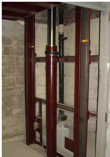
Σχήμα 1.3.3.1.2-1 : Άμεση ανάρτηση υδραυλικού ανελκυστήρα τύπου J2 [3].
