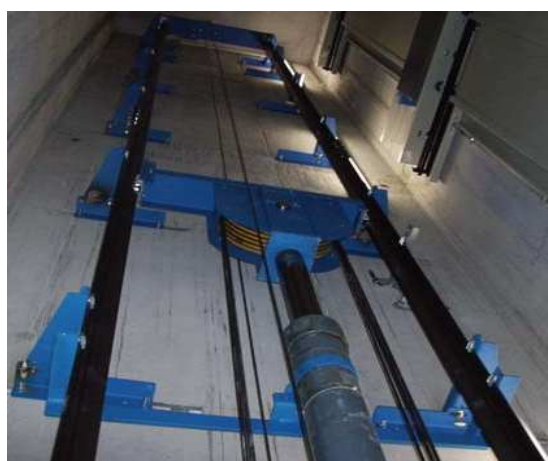
Σχήμα 1.3.3.2.1-1 : Έμμεση ανάρτηση υδραυλικού ανελκυστήρα τύπου L1 [3].
