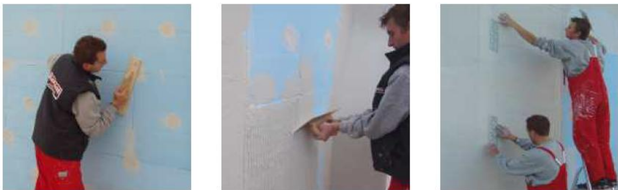
Εικόνα 6.3 Εξομάλυνση επιφάνειας, διάστρωση κόλλας, τοποθέτηση υαλοπλέγματος
