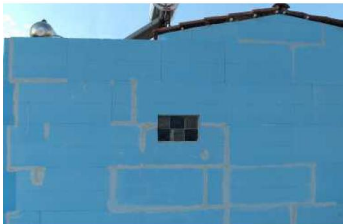
Εικόνα 6.2 Τοποθέτηση θερμομονωτικών πλακών
