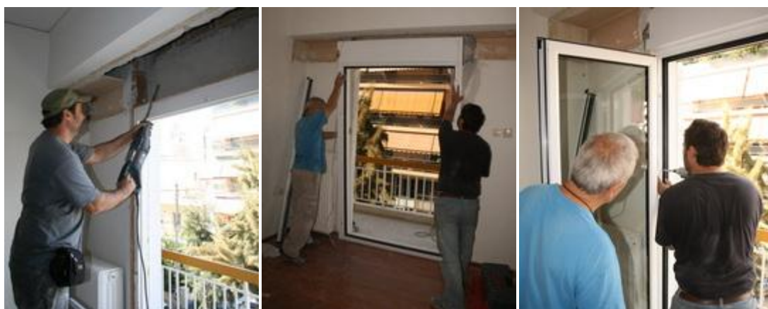
Εικόνα 6.5 Φάσεις αντικατάστασης παλαιών κουφωμάτων με εξωτερικό ρολό με νέα θερμομονωτικά κουφώματα
