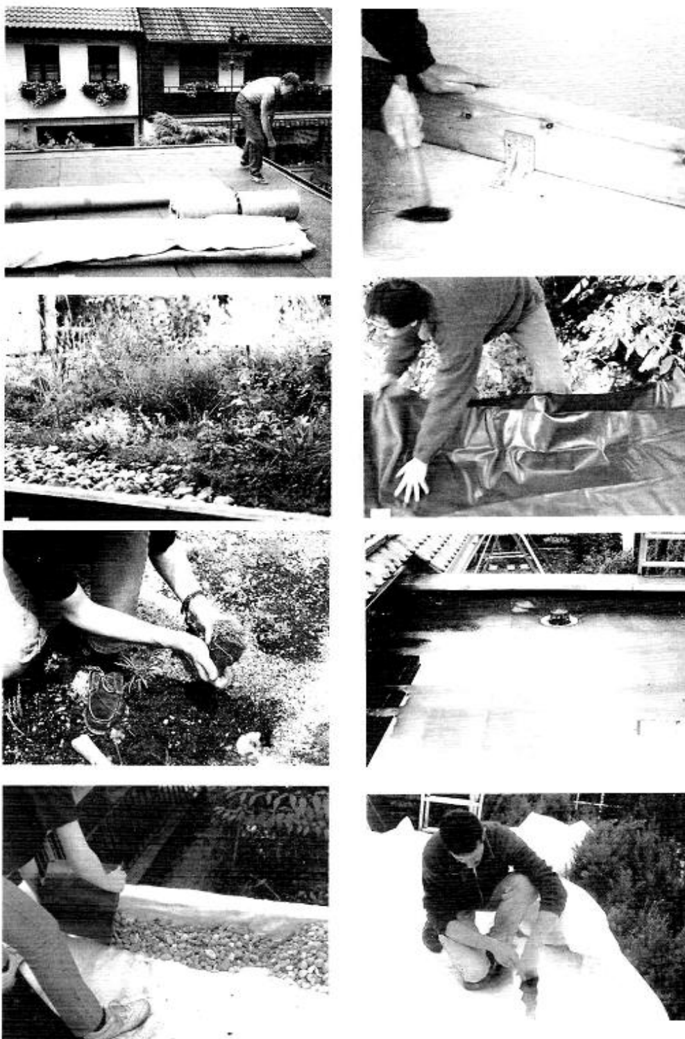
Εικόνα 2.7 Δημιουργία φυτεμένου δώματος στην οροφή κτιρίου
