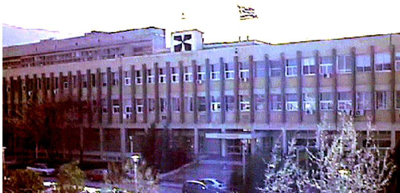
Εικόνα 4.1. Άποψη του Λαμπαδαρίου κτιρίου στην Πολυτεχνειούπολη Ζωγράφου.
