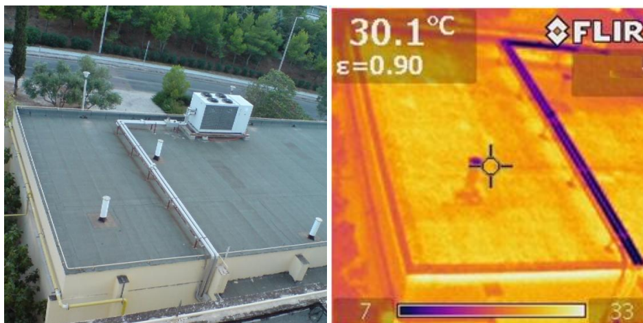
Εικόνα 5.18 Η οροφή της ανακαινιζόμενης πτέρυγας όπως φαίνεται από τον 3 ο όροφο του υπόλοιπου κτιρίου
