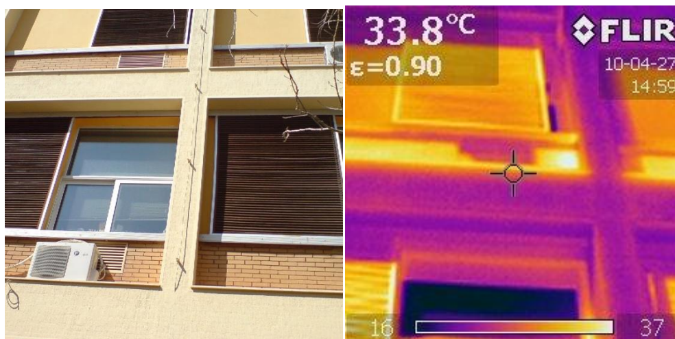
Εικόνα 5.10 Φωτογραφία του εξωτερικού του κτιρίου και αντίστοιχη λήψη στο υπέρυθρο φάσμα.
