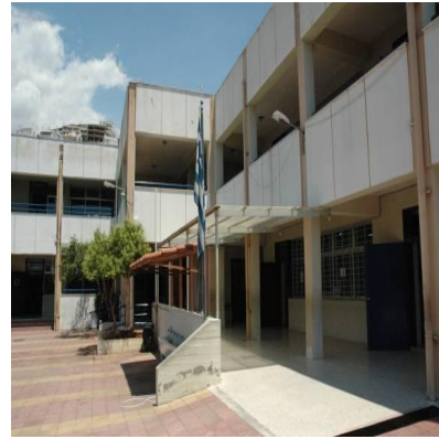
Δυτική όψη του κτιρίου
