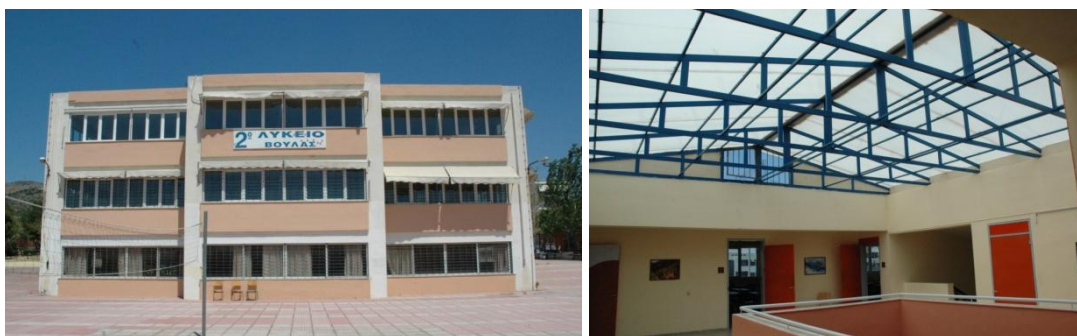
Εικόνα 5.25 Εξωτερική όψη του κτιρίου και αίθριο
