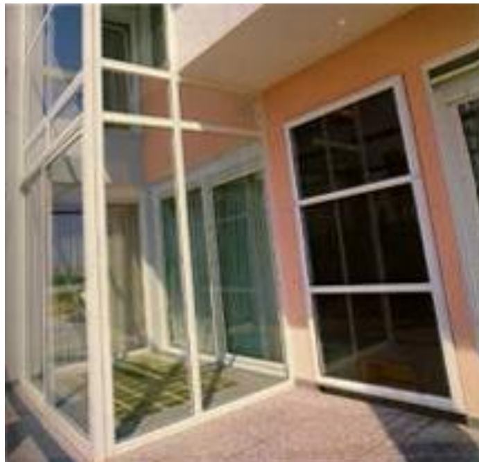
Εικονα 2.3 Χρήση θερμοκηπίου στο εξωτερικό κέλυφος του κτιρίου [15]
