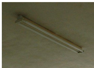
Εικόνα 5.8 Υπερβολικός αριθμός και απαρχαιωμένα φωτιστικά στις αίθουσες.
