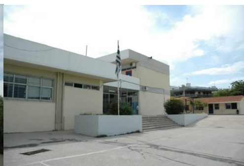
Δυτική όψη του κτιρίου
