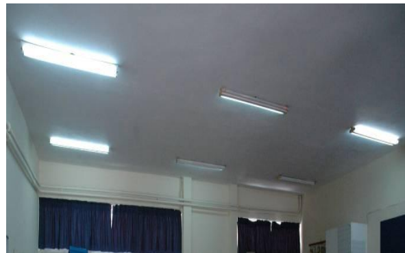
Εικόνα 7.3 Δραστική μείωση φωτιστικών στην αίθουσα ΒΙΒΛΙΟΘΗΚΗ Α με κατάλληλη μελέτη φωτισμού
