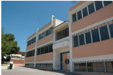
Βορειοδυτική όψη του κτιρίου
