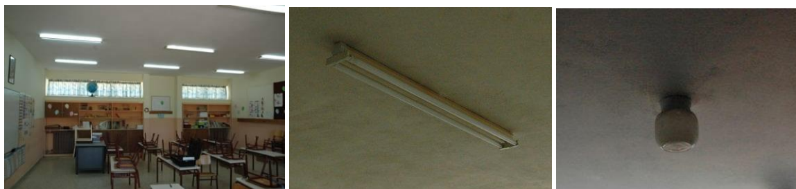
Εικόνα 5.11 Υπερβολικός αριθμός και απαρχαιωμένα φωτιστικά στις αίθουσες.
