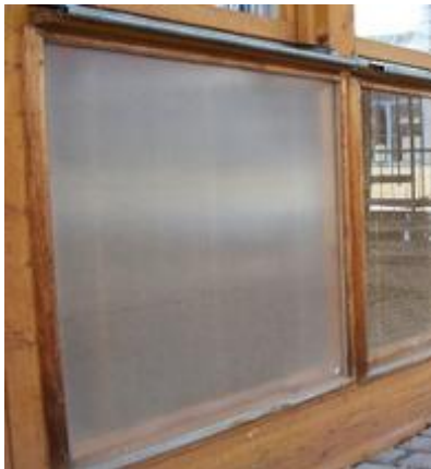
Εικόνα 4.6 Εφαρμογή διαφανών μονωτικών υλικών σε υαλοπίνακα (αριστερά) και σε τοιχοποιία (δεξιά) [15]
