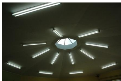
Εικόνα 5.8 Υπερβολικός αριθμός και απαρχαιωμένα φωτιστικά στις αίθουσες.
