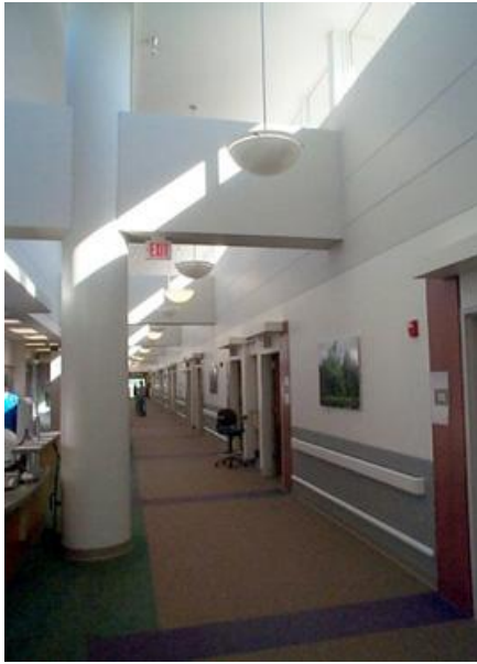
Εικόνα 4.8 Κατακόρυφα ανοίγματα οροφής [15]
