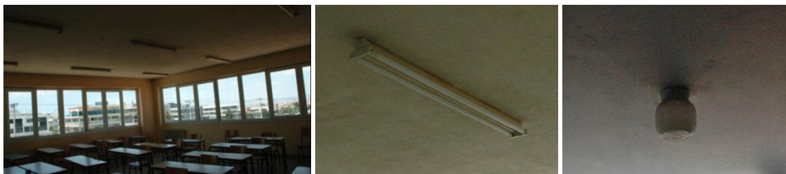
Εικόνα 5.10 Υπερβολικός αριθμός και απαρχαιωμένα φωτιστικά στις αίθουσες
