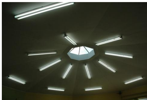
Εικόνα 7.1 Δραστική μείωση φωτιστικών στην αίθουσα 5 με κατάλληλη μελέτη φωτισμού
