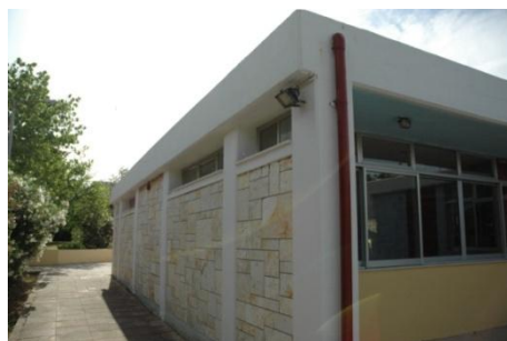
Δυτική όψη του κτιρίου
