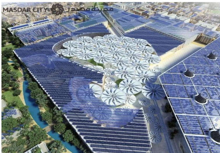
Εικόνα 4.14. Φωτοβολταϊκά πλαίσια στην Μάσνταρ
