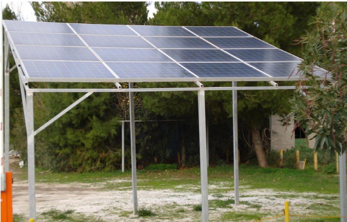
«Σχήμα Β.1, τα πανέλα της Φ/Β εγκατάστασης στο χώρο στάθμευσης του συνοικισμού “Μελτέμι” της Ραφήνας»
