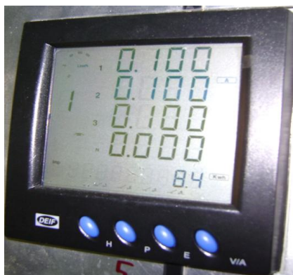
«Σχήμα Α.1, το πολυόργανο MIC της DEIF»
