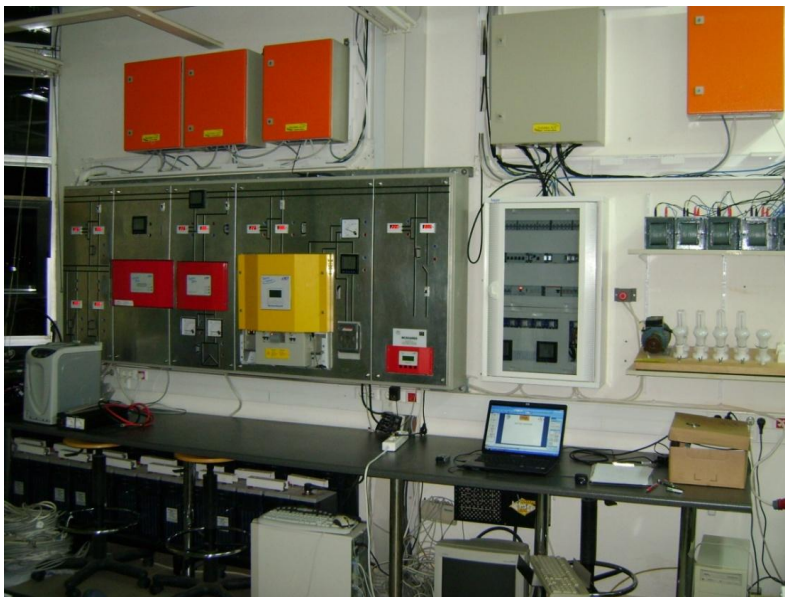
«Σχήμα 1.1, το μικροδίκτυο του εργαστηρίου ΣΗΕ της σχολής Ηλεκτρολόγων Μηχανικών του ΕΜΠ»
