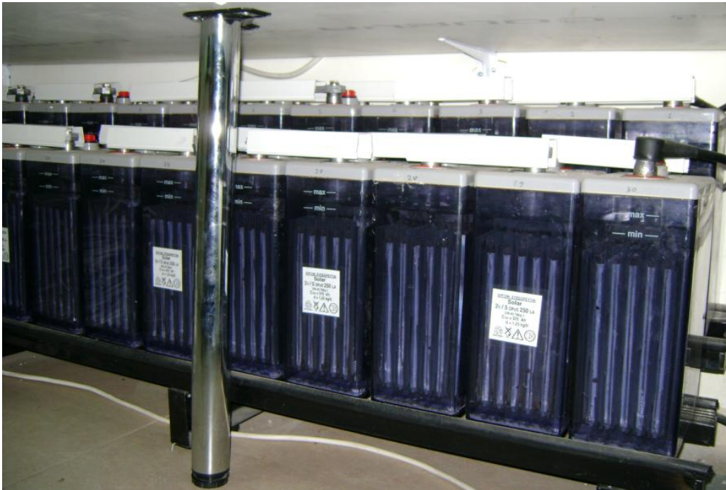
«Σχήμα 5.1, οι μπαταρίες μολύβδου-οξέως του μικροδικτύου του εργαστηρίου ΣΗΕ»
