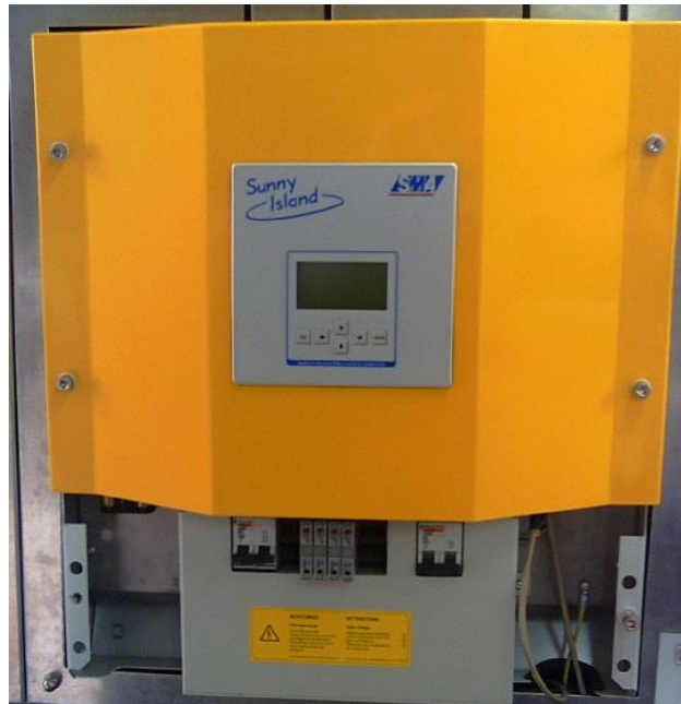
«Σχήμα 4.1, ο μετατροπέας των μπαταριών Sunny Island 4500 της SMA που βρίσκεται εγκατεστημένος στο εργαστήριο ΣΗΕ»
