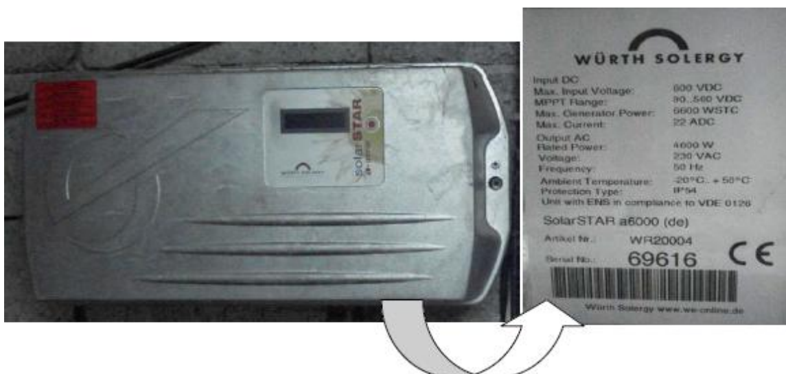
«Σχήμα Β.2, ο αντιστροφέας Würth Solergy του Φ/Β πάρκου στο Μελέμι της Ραφήνας»
