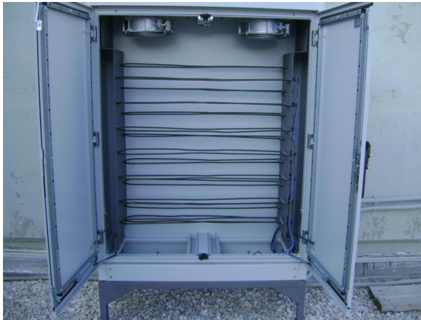
«Σχήμα 1.3, οι αντιστάσεις που εγκαταστάθηκαν στο μικροδίκτυο κατά τη διεξαγωγή της διπλωματικής εργασίας»
