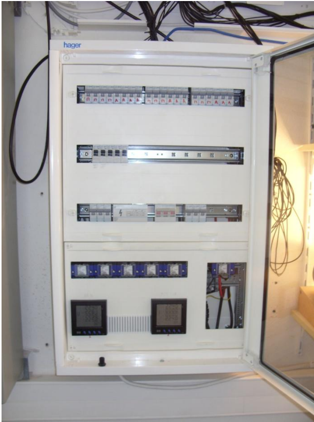
Εικόνα 2.16: Γενικός πίνακας εργαστηρίου
