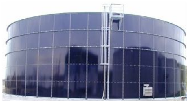
Σχήμα 4.2: Βιοαντιδραστήρας – Χωνευτήρας – Δεξαμενή Αναερόβιας Χώνευσης [25]
