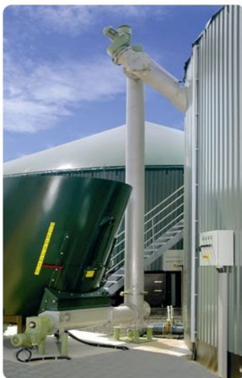
Σχήμα 4.3: Τροφοδότηση Βιομάζας με Κοχλία [25]
