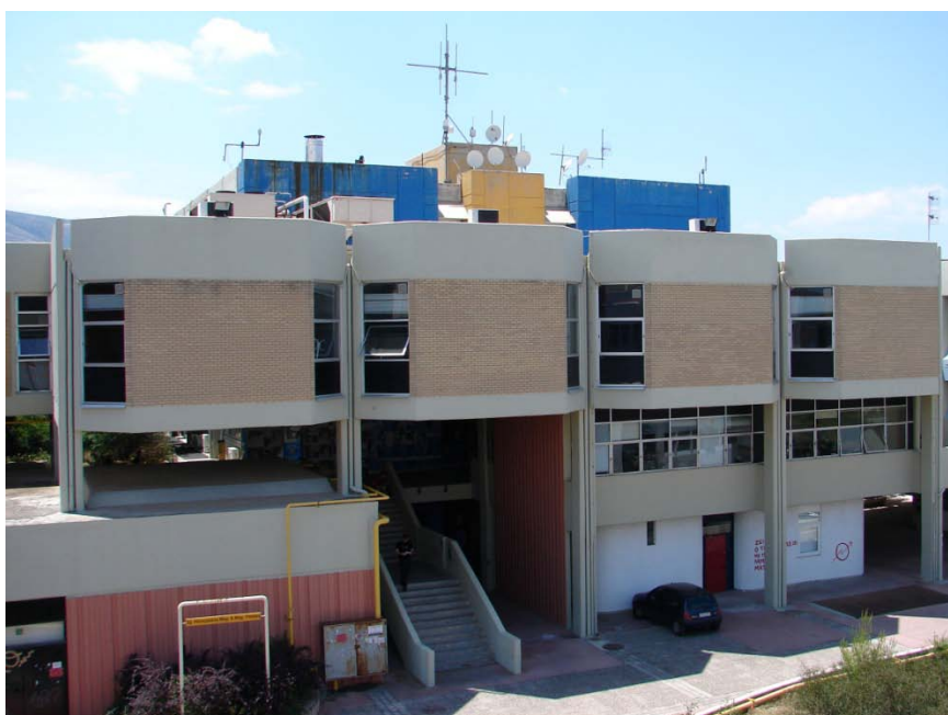
Εικόνα 3.3: Βόρεια όψη Κτιρίου HMMY – Α΄ Φάση
