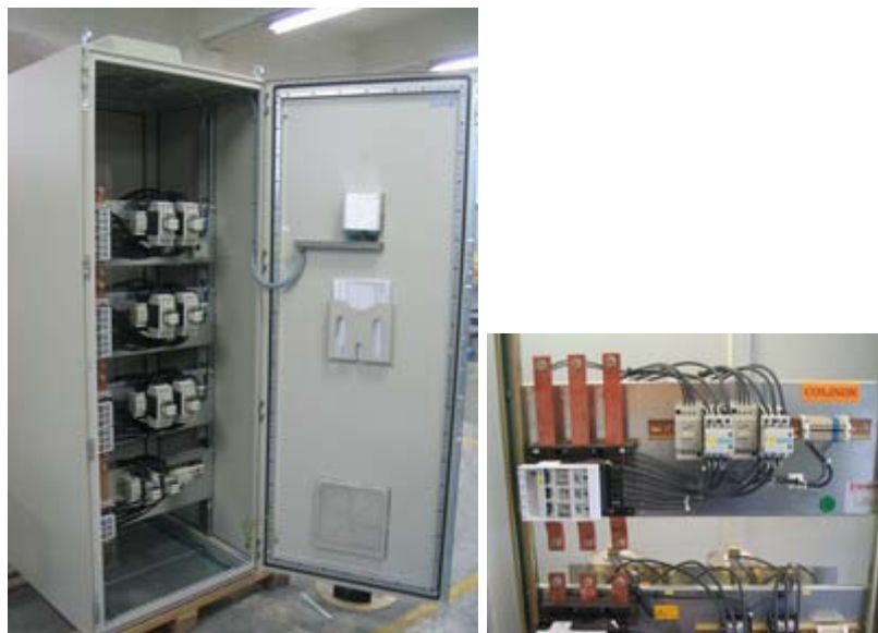
Εικόνα 5.3: Πίνακας αντιστάθμισης έργου ισχύος
