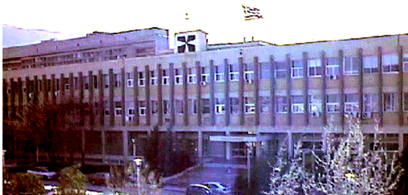
Εικόνα 4.2: Πρόσοψη Λαμπαδαρίου κτιρίου – Βορειοανατολική όψη
