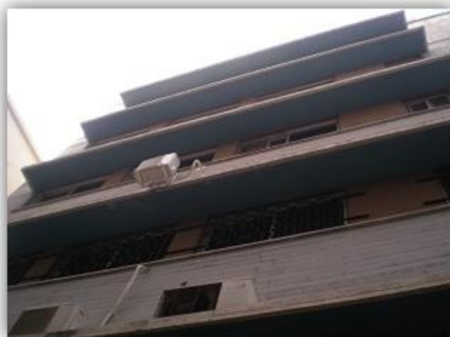
Εικόνα 3.6. Εξωτερική άποψη (Οπίσθια άποψη του κτιρίου)
