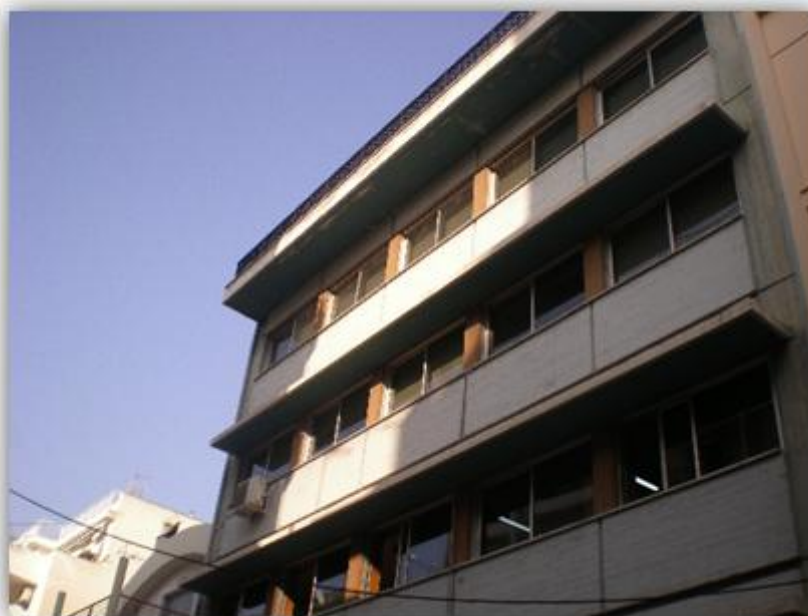
Εικόνα 3.3 Εξωτερική άποψη (2 ος , 3 ος , 4 ος όροφος)
