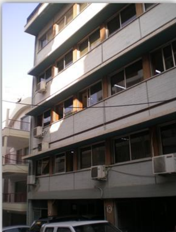
Εικόνα 3.1 Εξωτερική άποψη (Πιλοτή, 1 ος , 2 ος , 3 ος , 4 ος όροφος)
