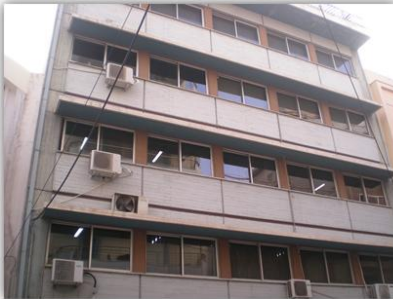
Εικόνα 3.4 Εξωτερική άποψη (1 ος , 2 ος , 3 ος , 4 ος όροφος)
