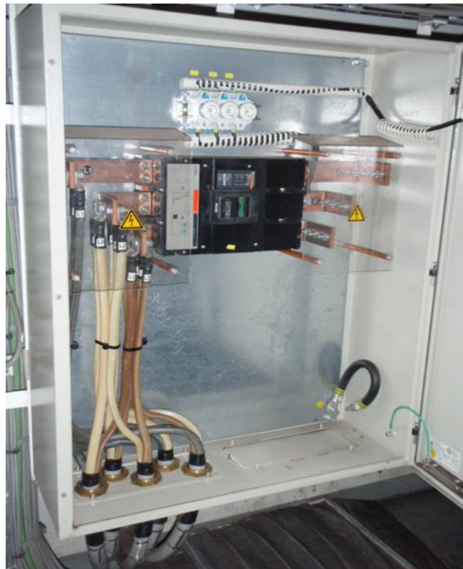
Σχήμα 10 - σύνδεση με ξηρά ( shore connection )
