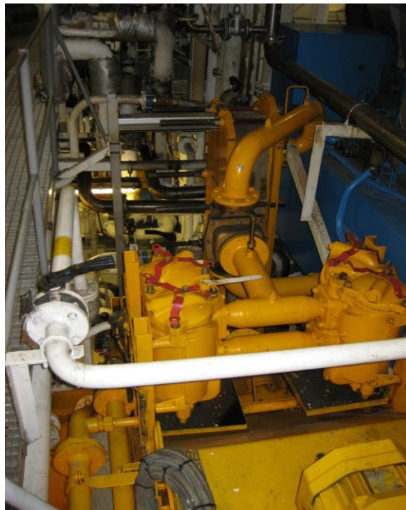
Σχήμα 7 - όψη του PTO εξαρτήματος από πάνω και σωληνώσεις λιπάνσεως
