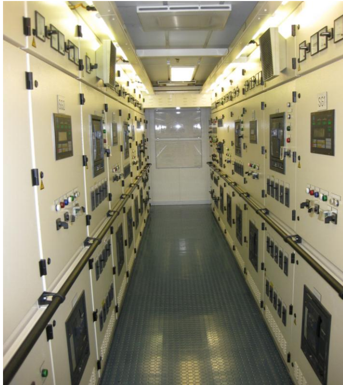
Σχήμα 9 - Κυψέλες πεδίων που συγκροτούν τον Κύριο Πίνακα των 440 V
