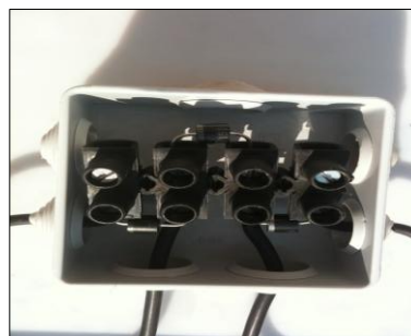
Σχήμα 4.22. Δίοδοι διέλευσης στο φωτοβολταϊκό με γυαλί στην οροφή του κτιρίου των Ηλεκτρολόγων
