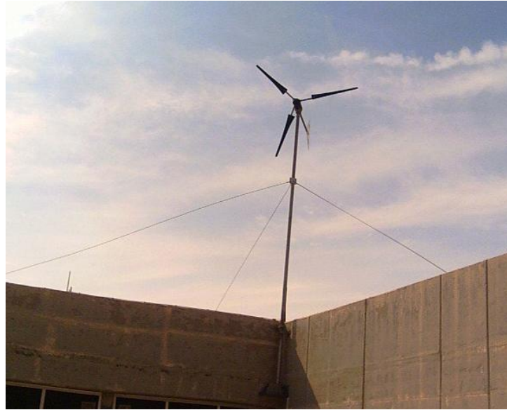
Εικόνα 2.12 Ανεμογεννήτρια στην ταράτσα του κτιρίου ηλεκτρολόγων
