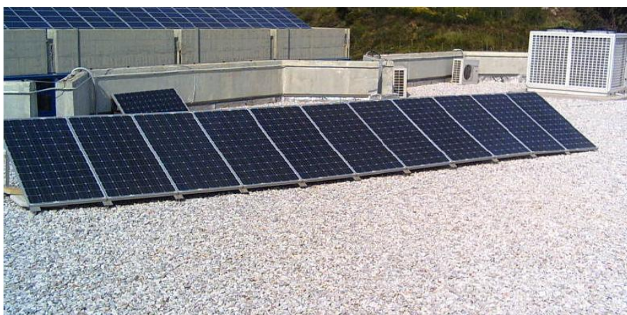
Εικόνα 2.4 Τα φωτοβολταϊκά πλαίσια στην ταράτσα των ηλεκτρολόγων
