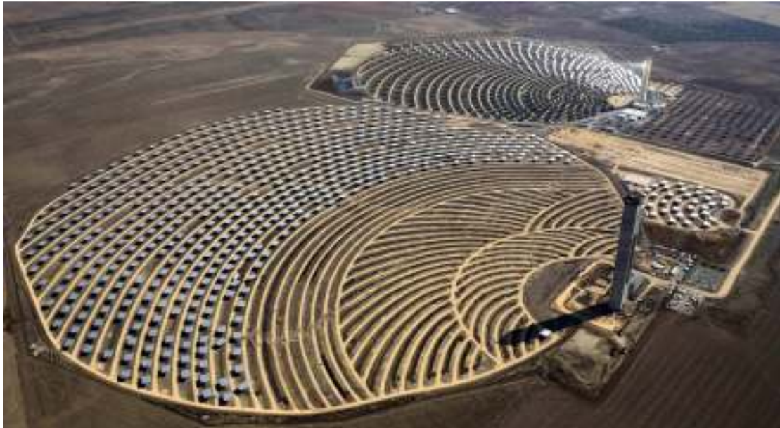
Σχήμα 2.12 Οι ηλιοθερμικοί σταθμοί ηλιακού πύργου PS20 (μπροστά) και PS10 (πίσω) στη Σεβίλλη της Ισπανίας [36]
