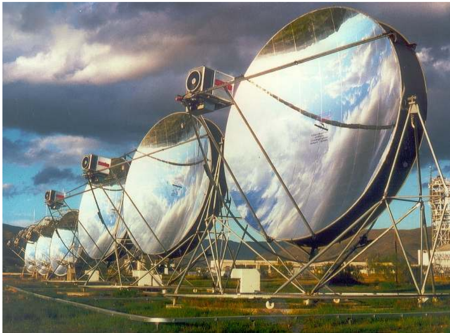
Σχήμα 2.13 Έξι παραβολικοί δίσκοι με μηχανές Stirling σε λειτουργία στο ερευνητικό κέντρο Plataforma Solar de Almería της Ισπανίας. Κάθε δίσκος παράγει 10kW ηλεκτρικής ισχύος [42].
