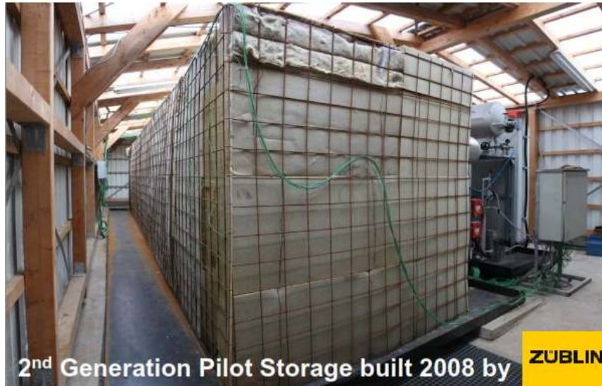
Σχήμα 2.21 Πειραματική διάταξη από σκυρόδεμα με δυνατότητα αποθήκευσης 400 kWh θερμικής ενέργειας. [54]
