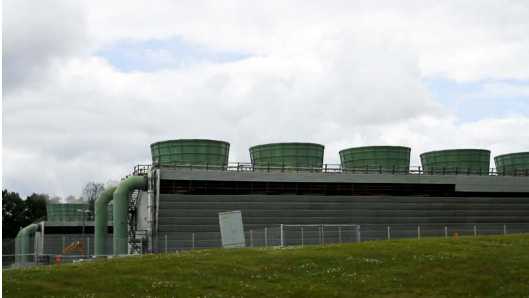
Σχήμα 3.17 Οι πύργοι ψύξης με αναρρόφηση του πυρηνικού σταθμού ηλεκτροπαραγωγής Vermont Yankee στις ΗΠΑ. [88]
