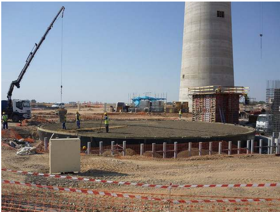
Σχήμα 2.19 Εργασίες κατασκευής των δεξαμενών αποθήκευσης τηγμένων αλάτων του ηλιοθερμικού σταθμού Gemasolar. [58]
