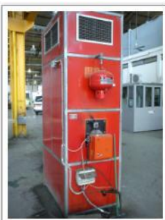
38. καυστήρας ΒΕΗ ΜΕΠ
