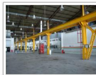
46. ανεμιστήρες, καμπάνα, χώρος
