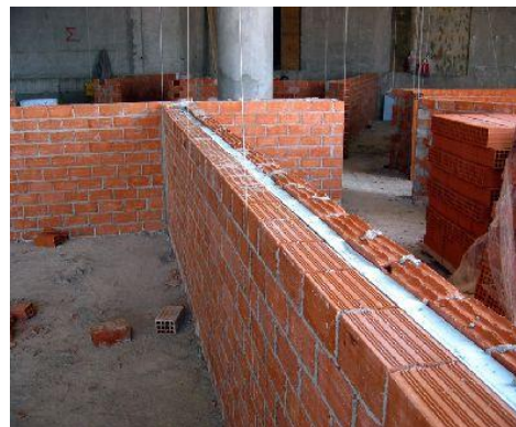
Σχήμα 9, Εικόνα 11 : Θερμομόνωση στο μέσον δύο τοίχων
