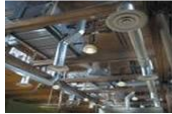
Εικόνα 15: Επιτοίχια χοάνη εξαερισμού και ελεύθερες χοάνες εξαερισμού
