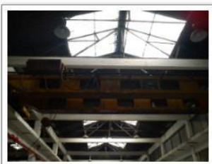
20.Γερανοέφευρα EUROIMPIANTI LATINA SPA 1,6tn
