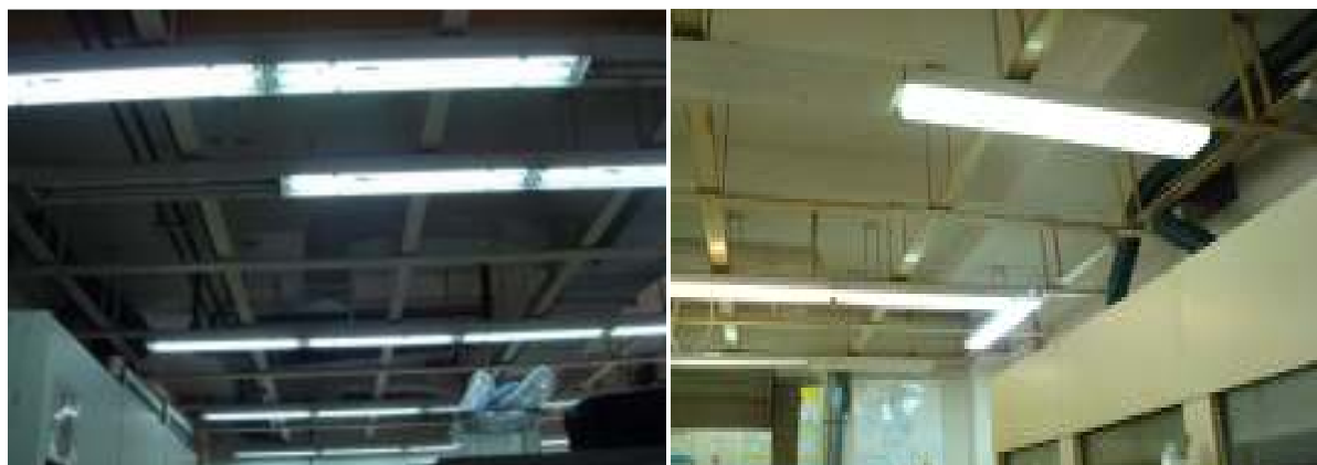
Εικόνα 5.1 : Μεγάλο μέρος της φωτεινής ακτινοβολίας των λαμπτήρων δεν κατευθύνεται στην επιφάνεια εργασίας λόγω απουσίας ανακλαστήρων
