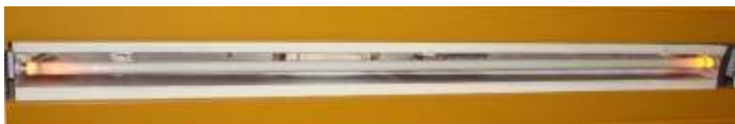
Σχήμα 4.18 : Φωτιστικό σώμα με ηλεκτρομαγνητικό ballast που καταναλώνει ενέργεια, παρόλο που οι λαμπτήρες δε λειτουργούν
