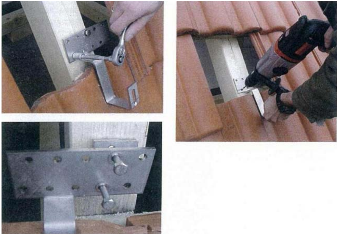
Σχήμα 3.33: Τοποθέτηση γάντζων στη στέγη για την ενσωμάτωση των πάνελ [5]
