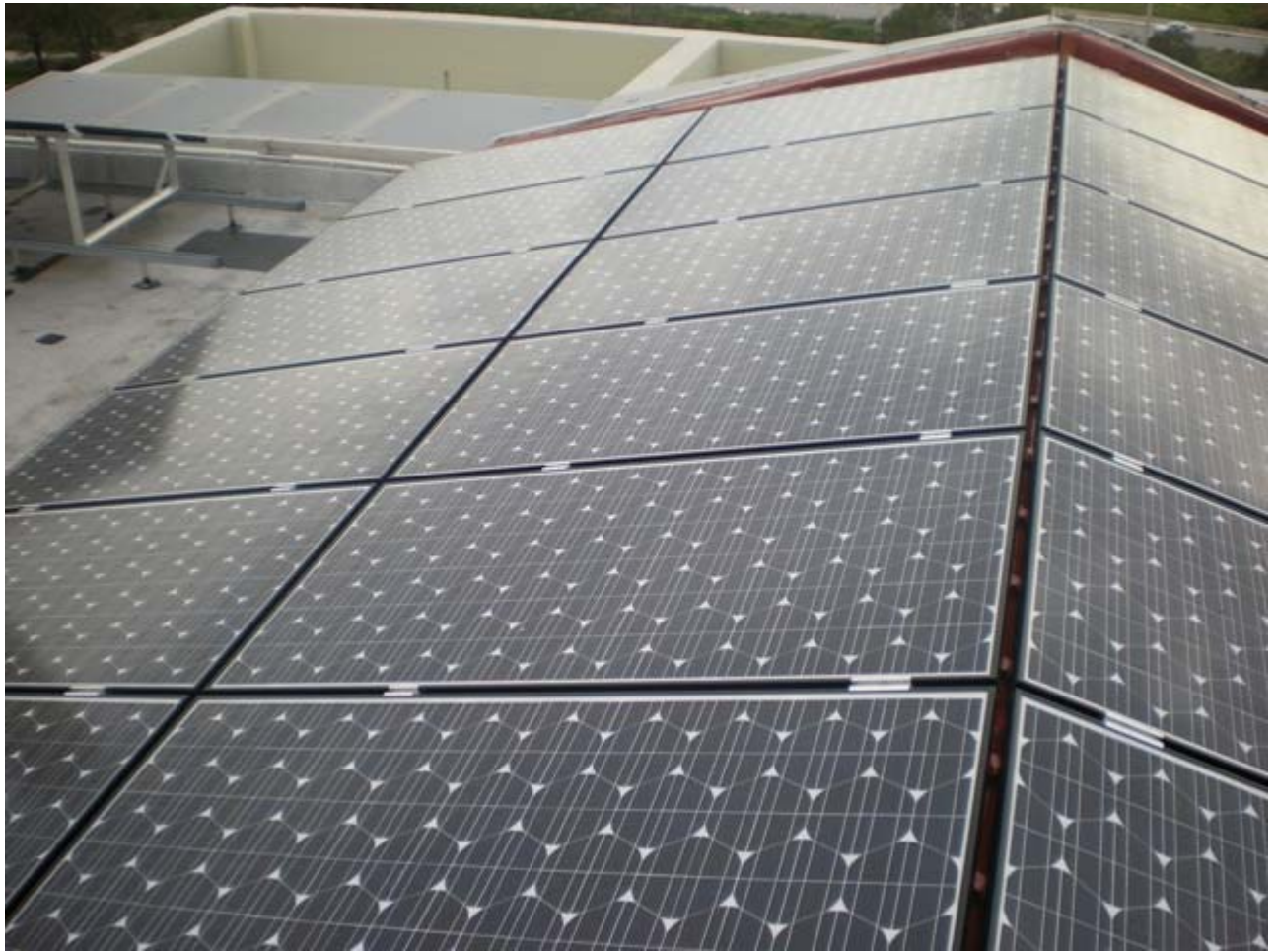
Εικόνα 10. 2: Φωτοβολταϊκό σύστημα ισχύος 8,64 Κρ στο Μοσχάτο
