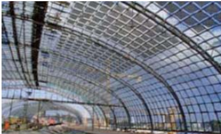
Εικόνα 2.3: Σιδηροδρομικός σταθμός Lehrter στο Βερολίνο με φ/β πλαίσια με διαφορετική καμπυλότητα και μέγεθος, 189kWp σε επιφάνεια 1.700m 2 . [4]
