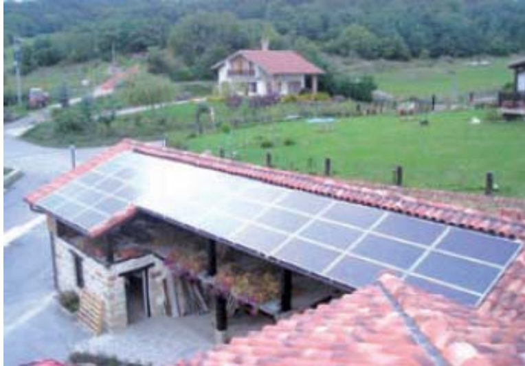
Εικόνα 2.2: Ενσωμάτωση φωτοβολταϊκών σε στέγη [4]
