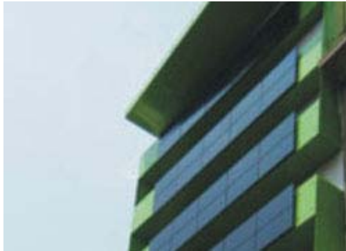
Εικόνα 2.5: Παράδειγμα φωτοβολταϊκού συστήματος ενσωματωμένο σε πρόσοψη κτιρίου στη Λ. Αλεξάνδρας
