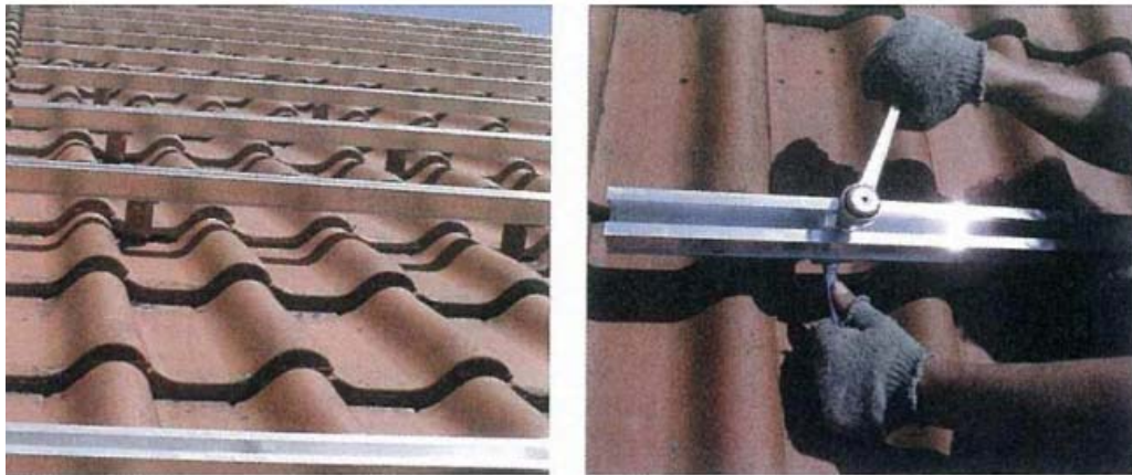
Σχήμα 3.34: Τοποθέτηση ράγων
