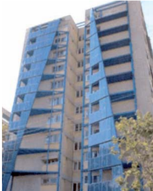
Εικόνα 2.4: Παράδειγμα ενσωμάτωσης φωτοβολταϊκού σε πρόσοψη κτιρίου στο Ταύρο-Αθήνα [4]
