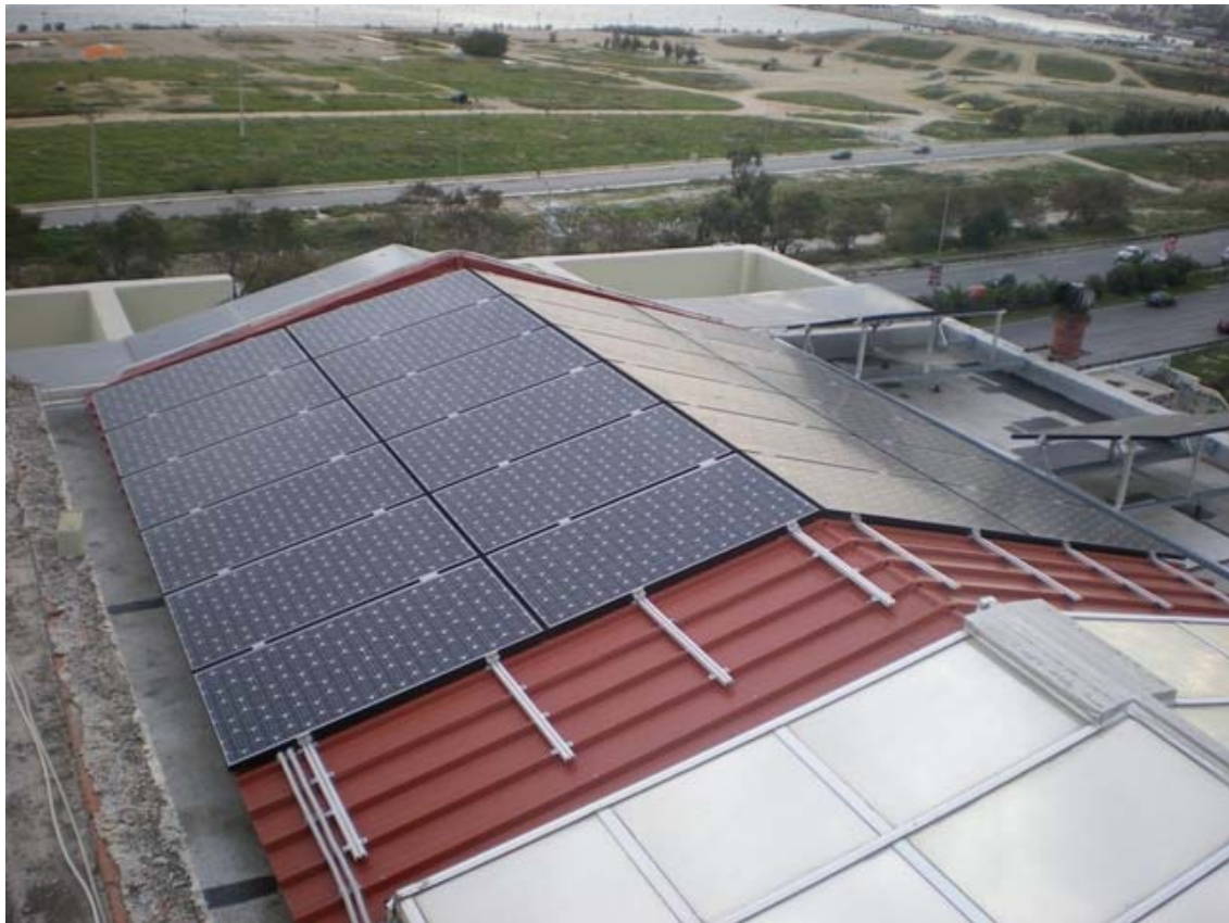
Εικόνα 10.1: Φωτοβολταϊκό σύστημα ισχύος 8,64 Κρ στο Μοσχάτο
