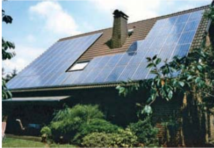
Εικόνα 2.1: Τοποθέτηση φωτοβολταϊκών στην επιφάνεια τις στέγης
