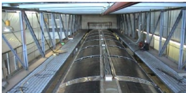
Εικόνα 24: Εγκατάσταση διατάξεων στο πρώτο βαγόνι
