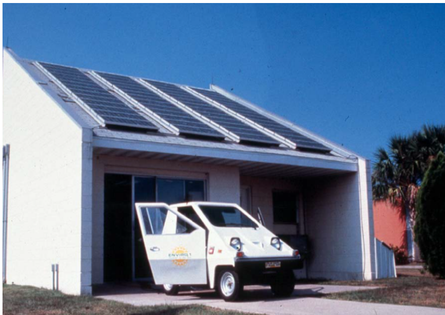
Εικόνα 45: CityCar EV που φορτίζεται από φωτοβολταϊκή συστοιχία
