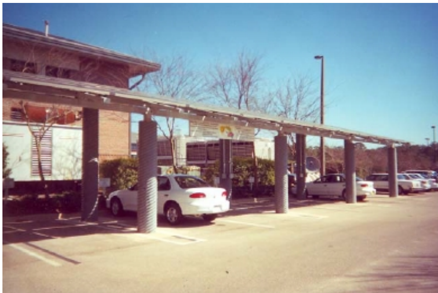
Εικόνα 49: Υπόστεγο στάθμευσης αυτοκινήτων EV με 18 kW από πλέγμα Φ/Β για τη φόρτιση EV που βρίσκεται στο Κυβερνητικό Κέντρο του Ταλαχάσι (1996)
