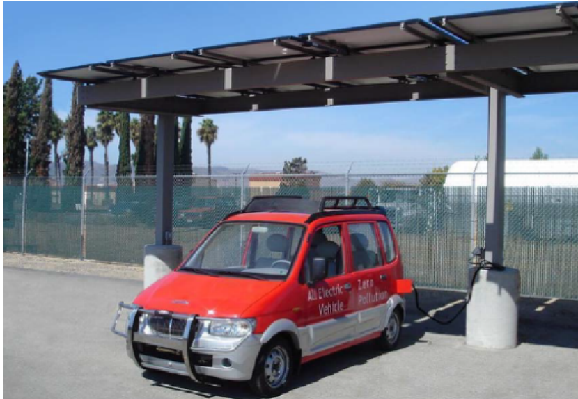
Εικόνα 48: Miles OR70 ηλεκτρικό όχημα σε δίκτυο συνδεδεμένων φωτοβολταϊκών φόρτισης σε υπόστεγο στάθμευσης στο MCB Camp Pendleton
