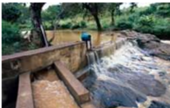
Εικόνα 5.5-3: Εκτροπή νερού ποταμού προς υδροηλεκτρικό μικρής κλίμακας.
