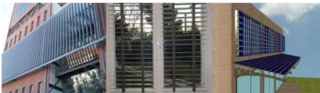
Εικόνες 5.2-4(α)-4(β)-4(γ): Συστήματα παθητικού δροσισμού με εξωτερικές ανοιγοκλειόμενες περσίδες, περσίδες εσωτερικού χώρου και φωτοβολταϊκά σκιάδα.
