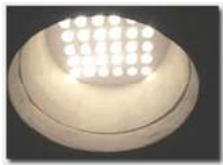
Εικόνες 5.2-19: Ανοιγμα στην οροφή ενός χώρου για εκμετάλλευση του φυσικού φωτισμού.
