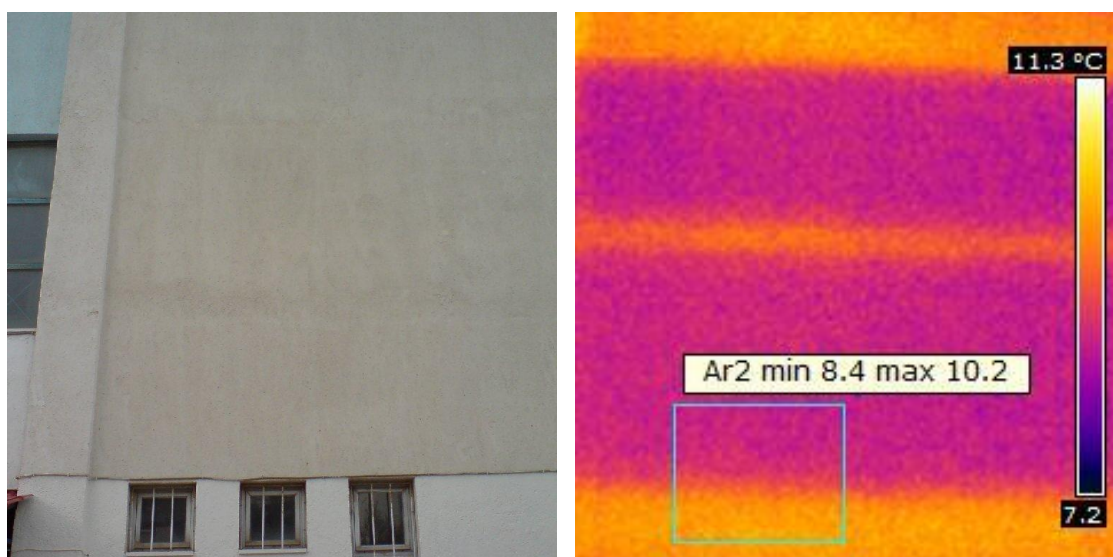
Εικόνα 4.7: Πλάγια όψη κτιρίου: στην πρώτη φωτογραφία ξεχωρίζει ο φέρον οργανισμός του κτιρίου από την τοιχοποιία πλήρωσης.
