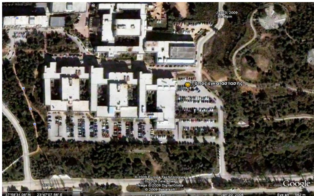
Εικόνα 4.1 - Αποψη του χώρου εγκατάστασης
