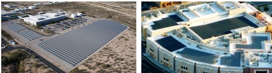
Εικόνες 1.13 – 1.14 –Εγκαταστάσεις με πλαίσια CIGS
