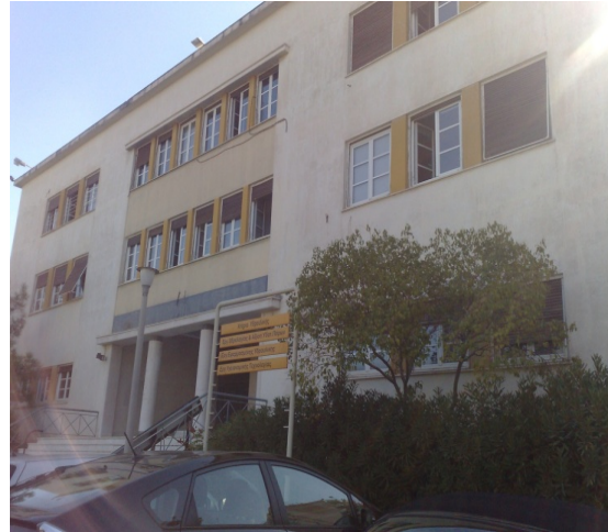
Εικόνα 5.3: Βορειοδυτική όψη κτιρίου.
