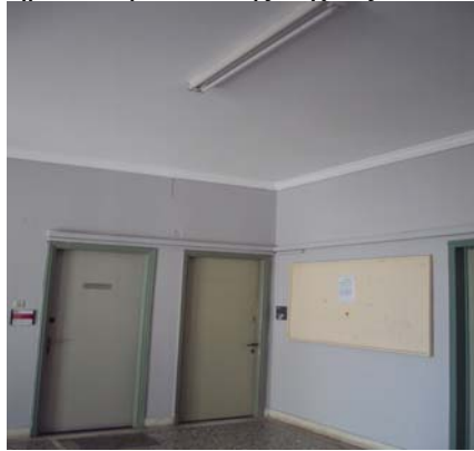
Εικόνα 5.6: Χρήση φωτιστικού με λαμπτήρα T8.
