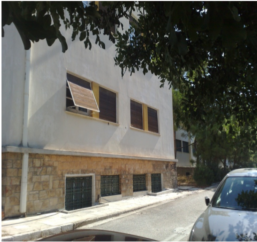
Εικόνα 5.2: Νοτιοδυτική όψη κτιρίου.
