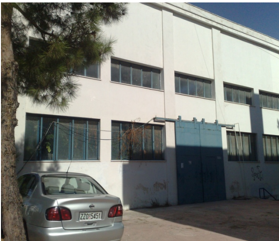
Εικόνα 5.4: Νοτιοανατολική όψη κτιρίου.
